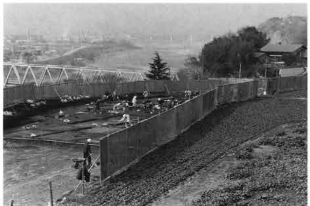
8 調査風景(西に安全柵・北に防塵ネット)
