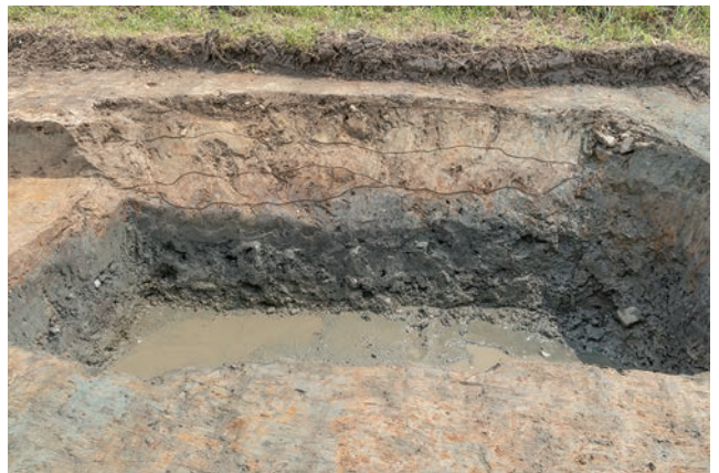
(4)D2トレンチ南壁断面(北から)
