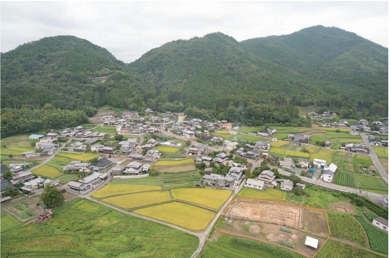
(2) A1 地区全景(北東から)
