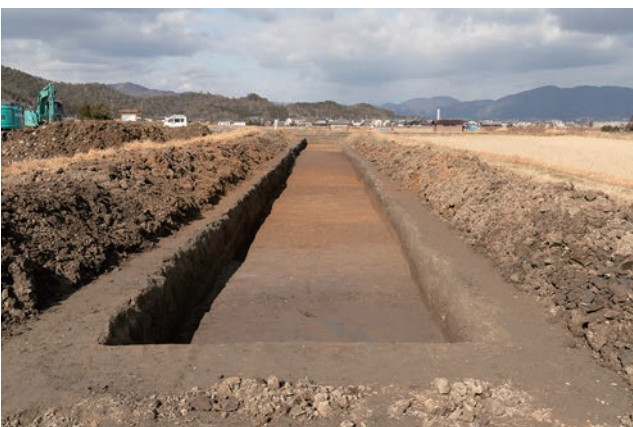
(7) C4トレンチ全景(南から)
