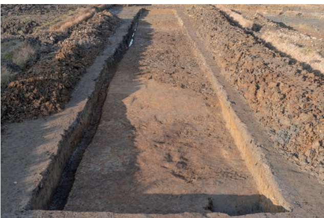
(7) B6トレンチ全景(南から)
