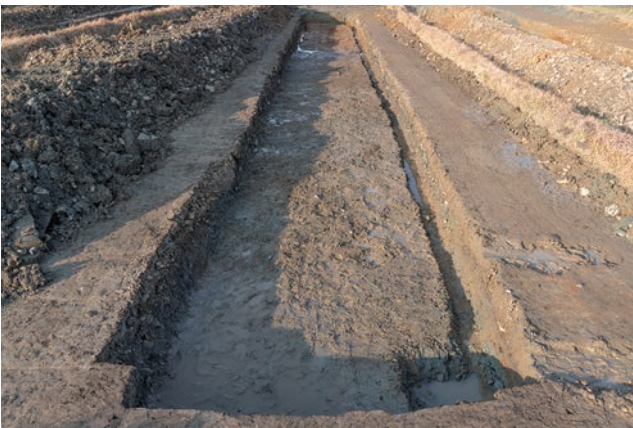
(3)B8トレンチ全景(南から)
