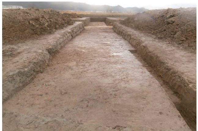
(4) B3トレンチ全景(南から)
