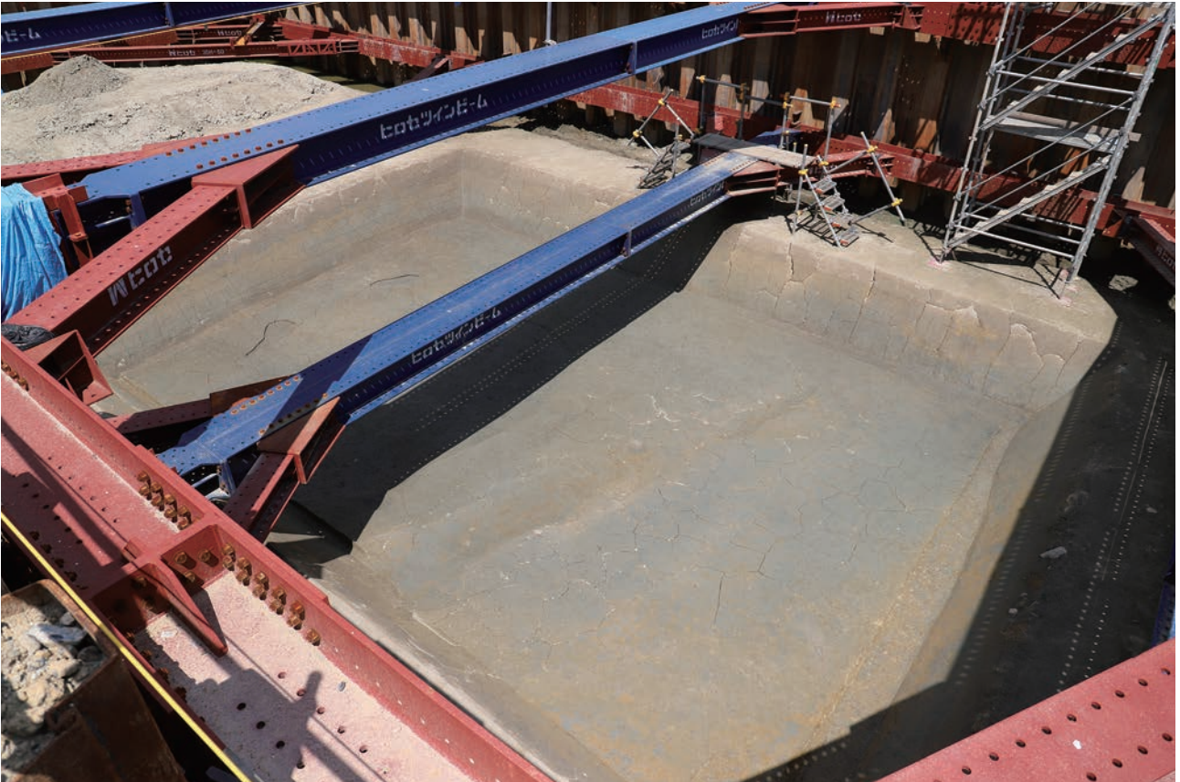
(1) F21区基盤層面完掘状況(南西から)
