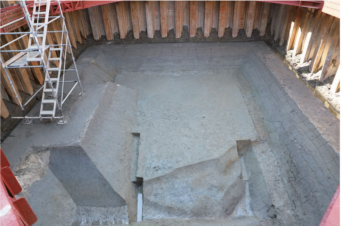
(1) F22区完掘状況(東から)
