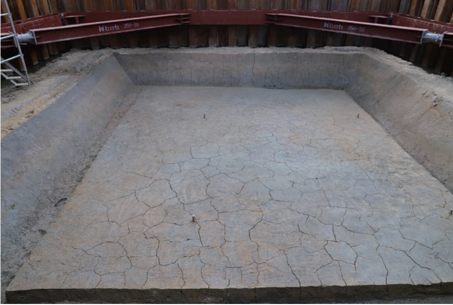
(1) F16区完掘状況(東から)
