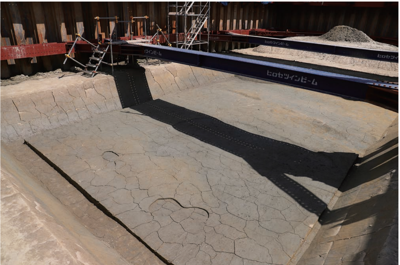
(2) F21区基盤層面完掘状況(北西から)
