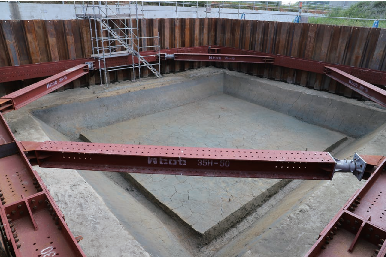
(1) F16区完掘状況(北東から)
