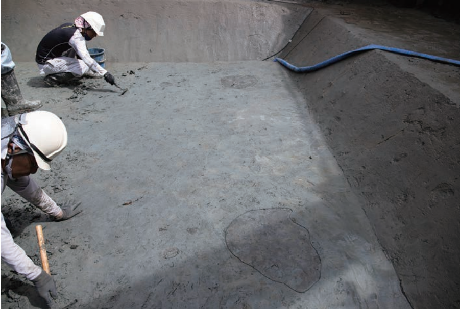
(1) F21区中世面遺構検出状況 (南から)
