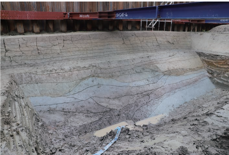
(3) F21区下層調査東壁断割 土層断面(北西から)
