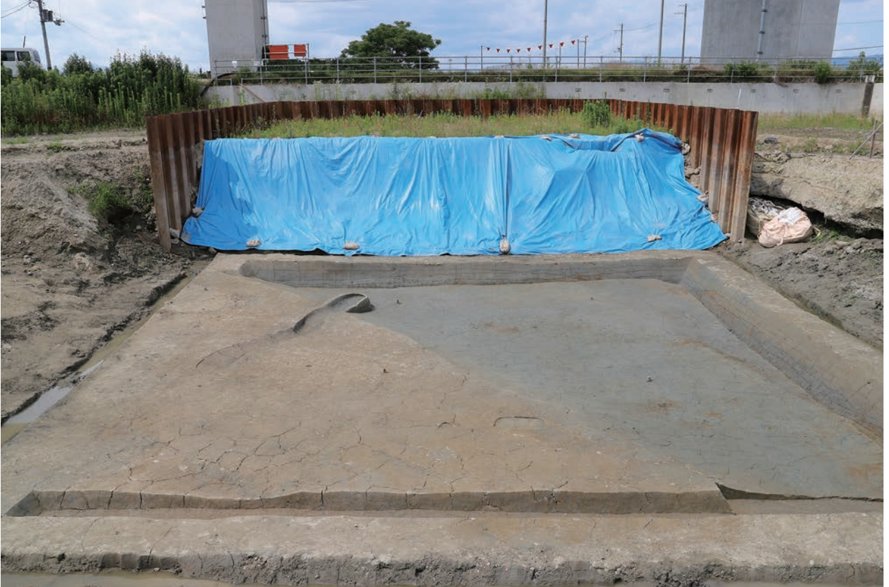
(1) F19区完掘状況(南から)
