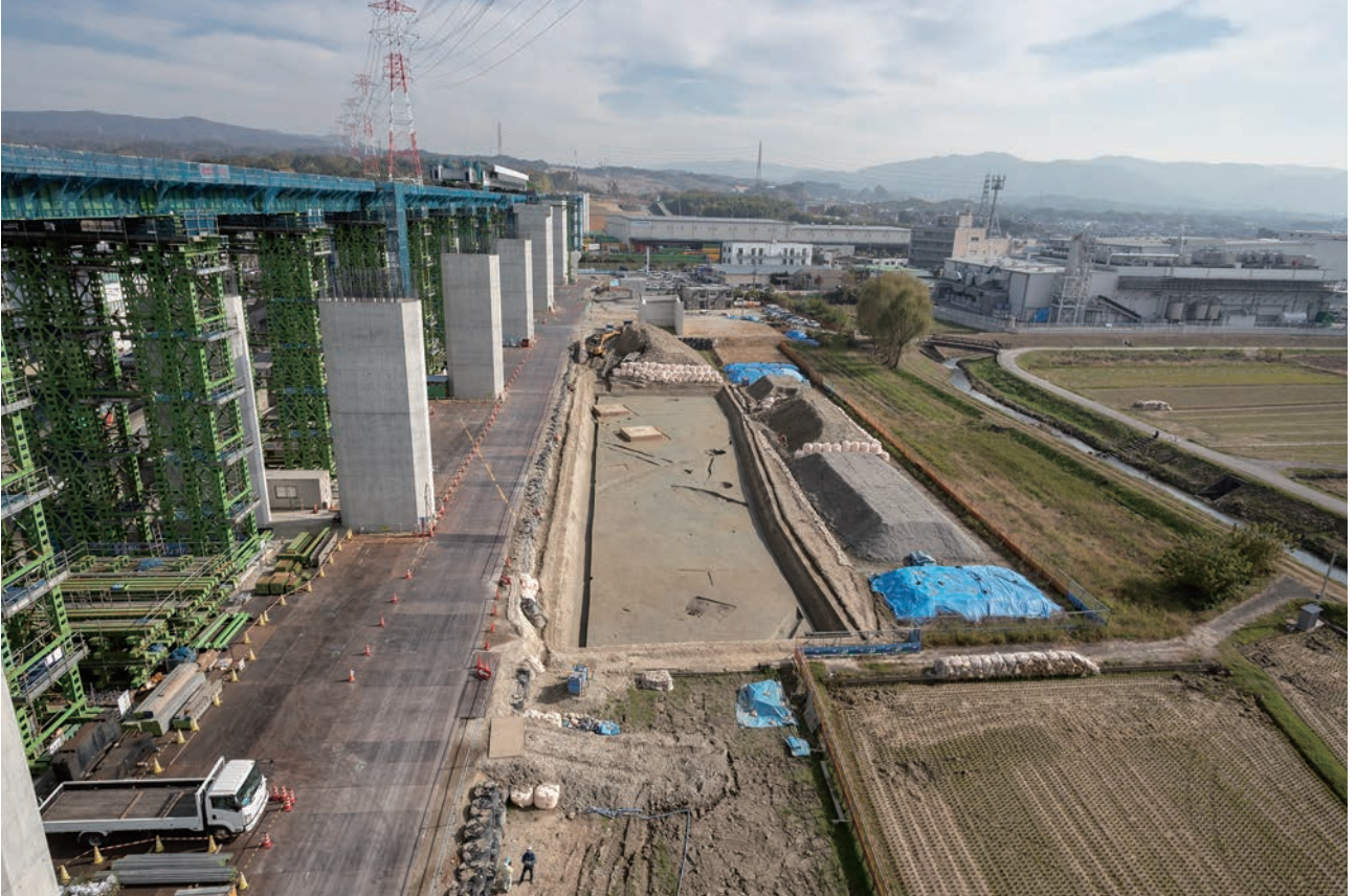
(1) 調査地西半遠景(西から)
