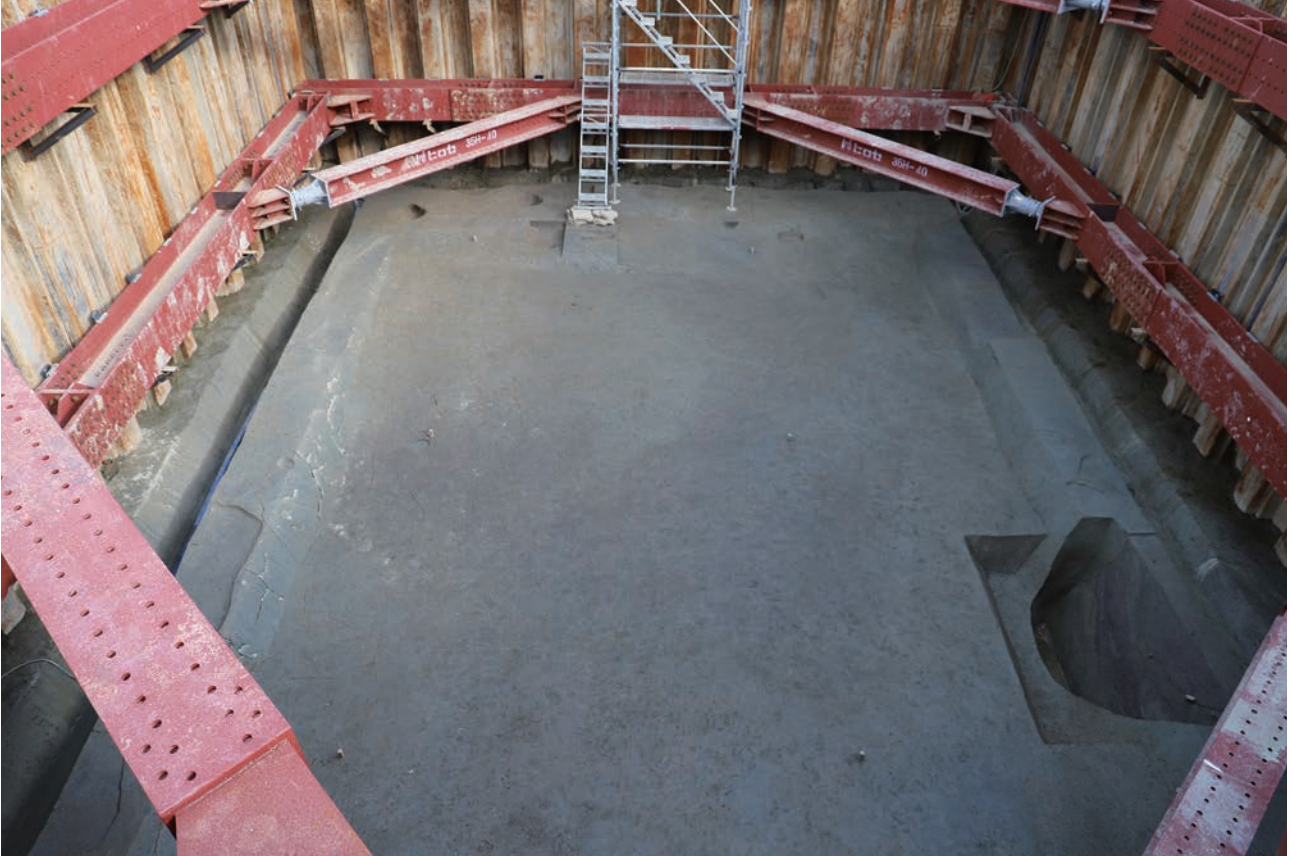
(1) F17区基盤層面完掘状況(西から)
