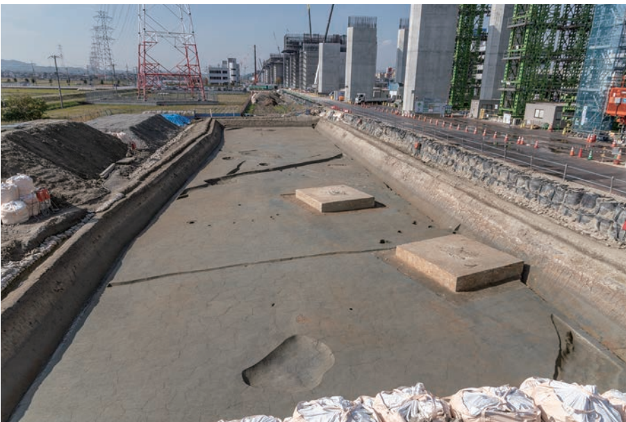
(3) 調査トレンチ西半全景 (東から)
