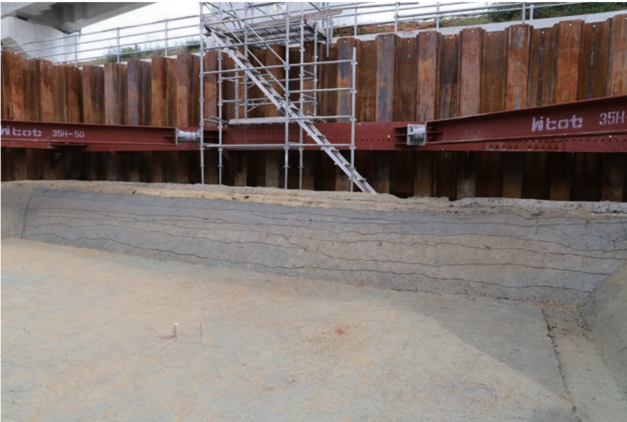
(2) F16区北壁土層断面 (北西から)
