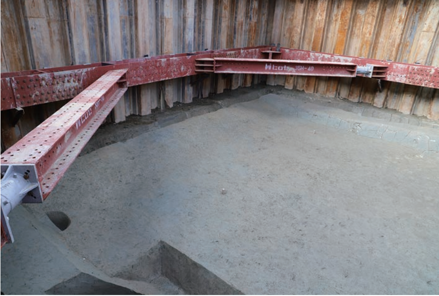
(1) F17区基盤層面高畑110 (南東から)
