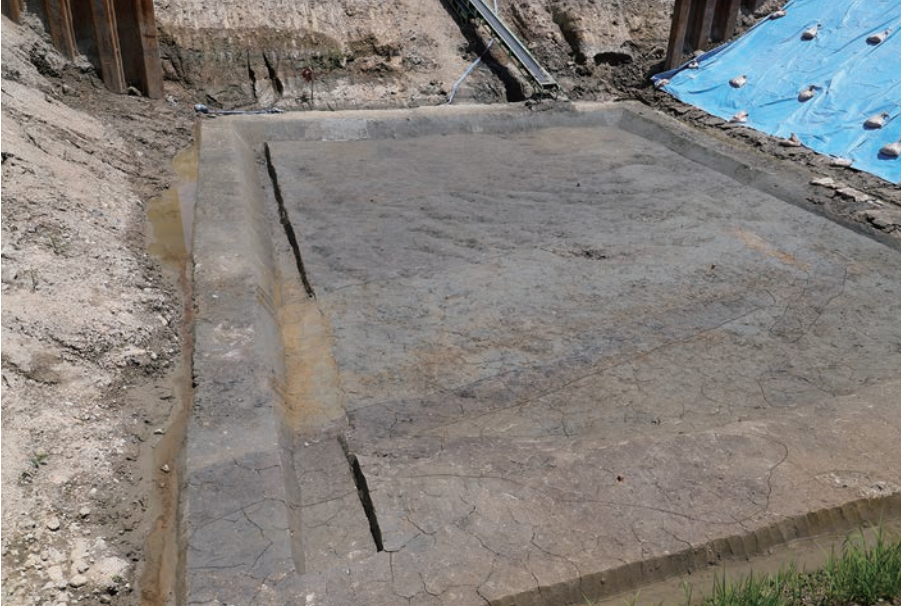
(1) F 20区遺構検出状況 (北西から)
