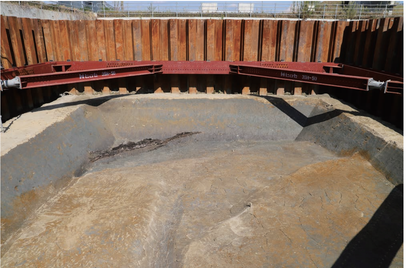
(2) F15区完掘状況(西から)
