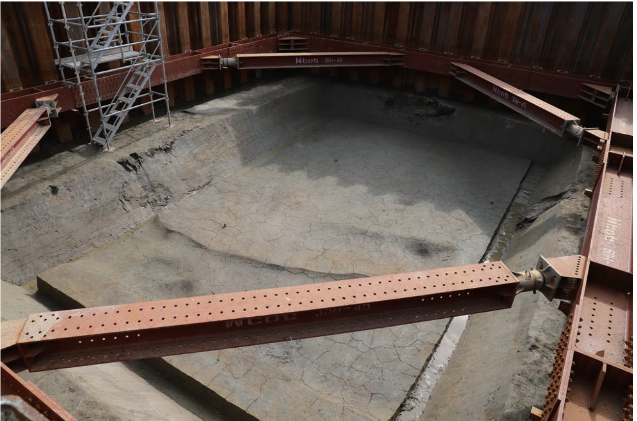
(2) F14区完掘状況(北東から)
