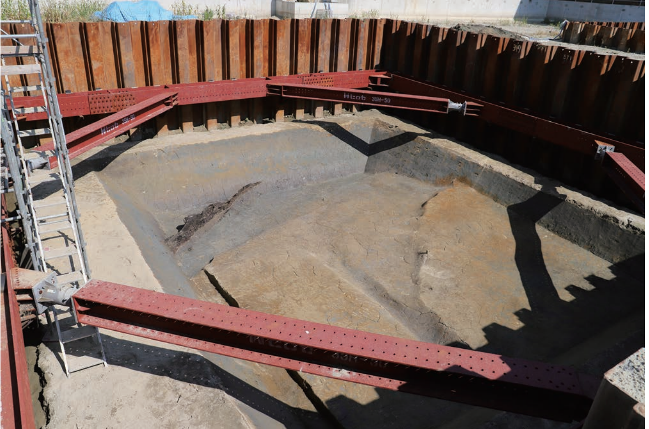
(1) F15区完掘状況(北西から)
