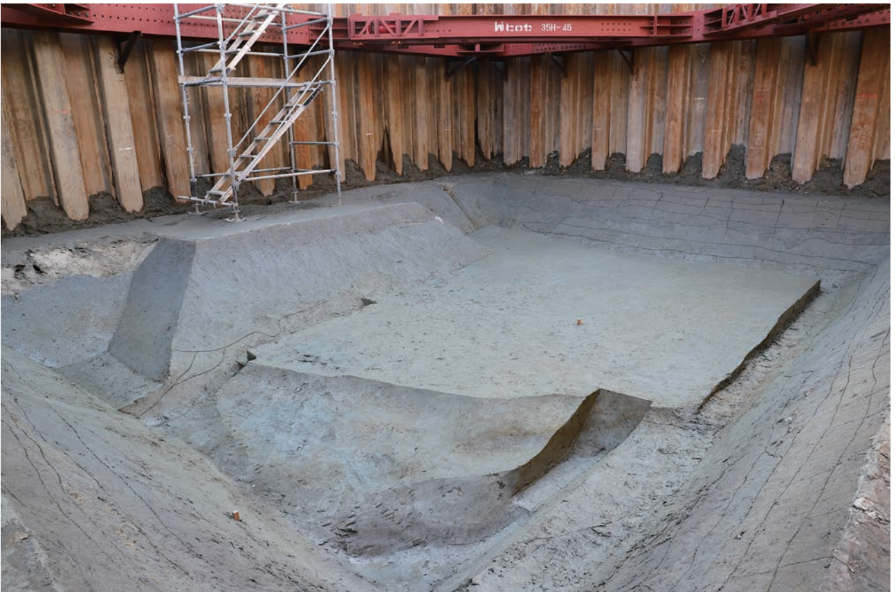
(2) F22区完掘状況(北東から)
