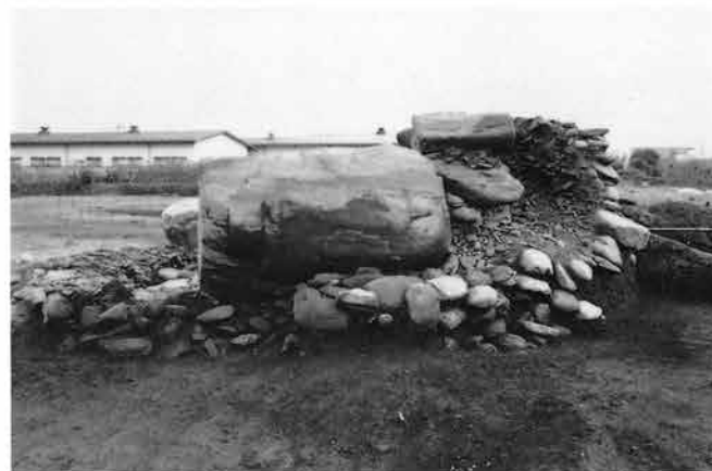
6 奥壁石設置のための下部補強
