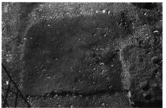
8 40号住居跡床下
