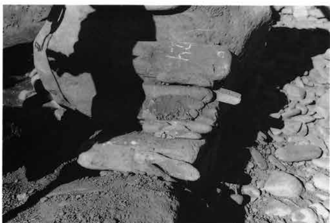
3 羨道左壁構築状況
