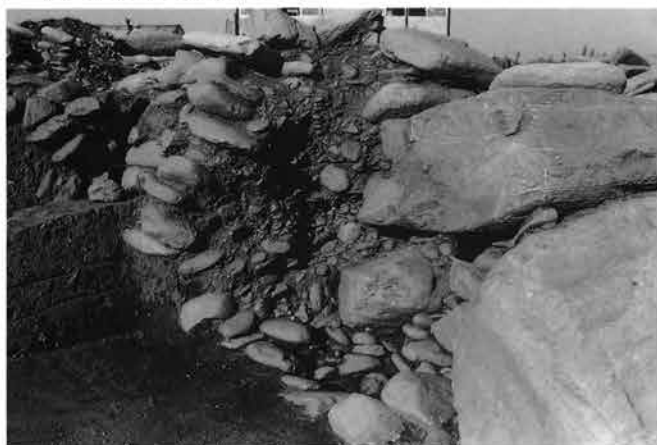
3 羨道左壁の裏込め状態
