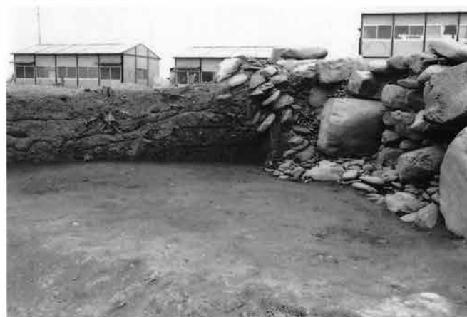
4 玄室左壁の裏込め状態
