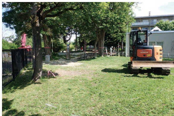
A 事業地近景 (南から)
