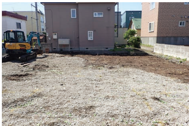
A 事業地近景 (北から)
