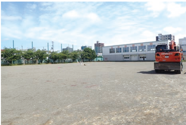
D 事業地近景 (南西から)
