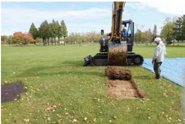
E 掘削状況
