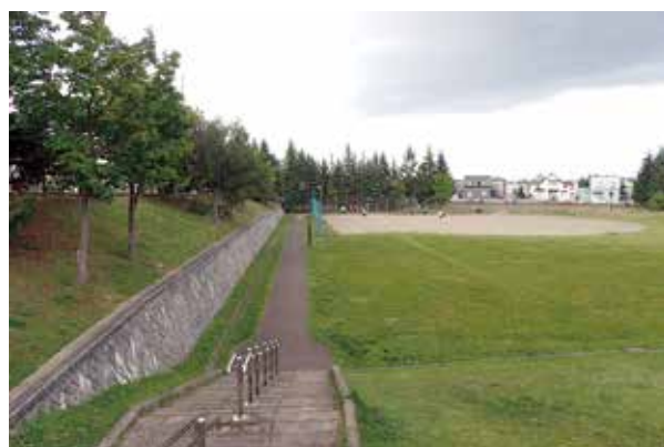
D 整理番号 21-3-306 事業地近景 (南西から)
