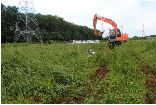
A 事業地近景 (南から)
