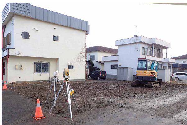
E 事業地近景 (西から)
