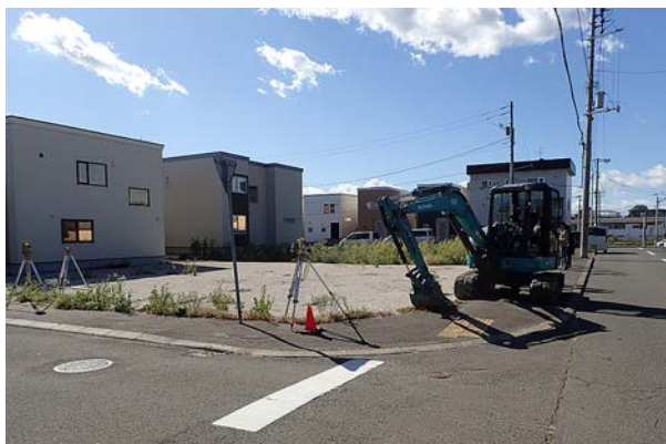
A 事業地近景 (北西から)
