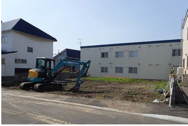
A 事業地近景 (北西から)
