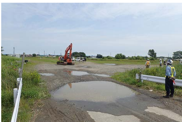
E 事業地近景 (南西から)
