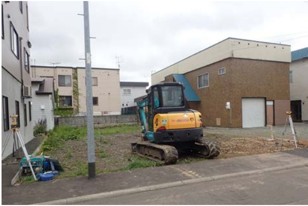
A 事業地近景 (北から)
