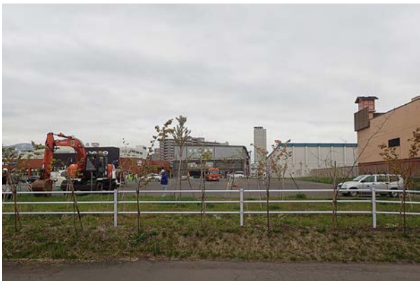
E 事業地近景 (南東から)
