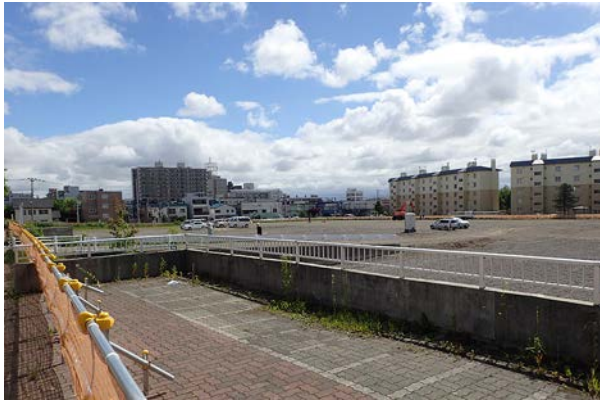
A 事業地近景 (南西から)
