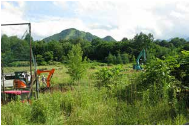
A 事業地近景 (北から)
