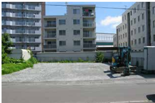
A 事業地近景 (南西から)
