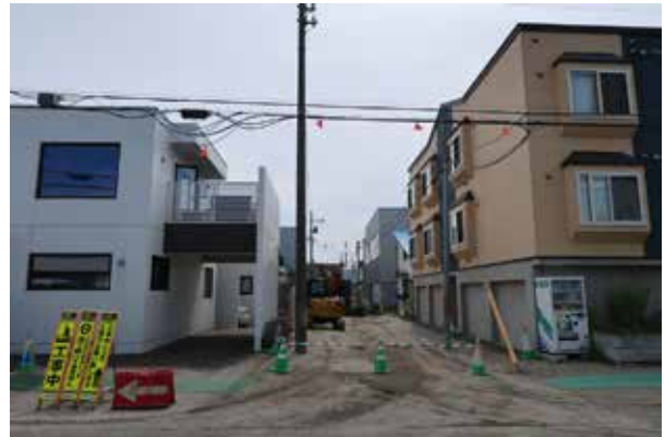
D 事業地近景 (北西から)
