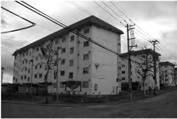
A 整理番号15-3-321 事業地近景（西から）
