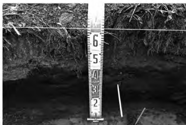
F 工事立会 土層断面
