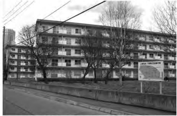
B 整理番号15-3-321 事業地近景（南から）
