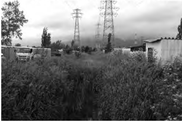
A 事業地近景 (北東から)
