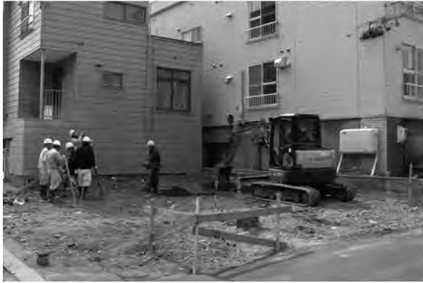
A 事業地近景（北から）
