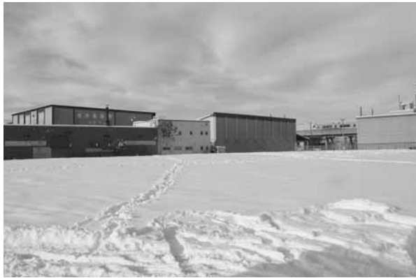
A 事業地近景(南から)
