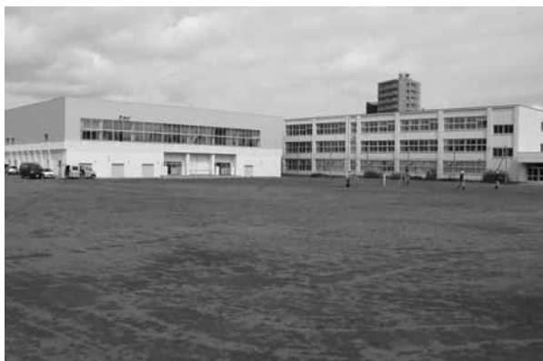
A 事業地近景(南から)
