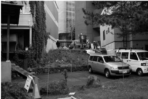
E 事業地近景(北西から)
