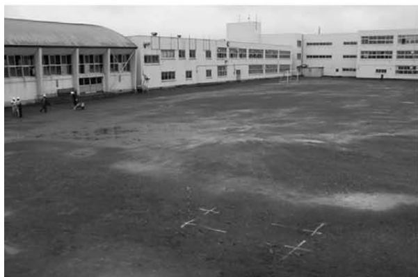
A 事業地近景(北から)
