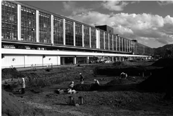
A 事業地近景(北西から)
