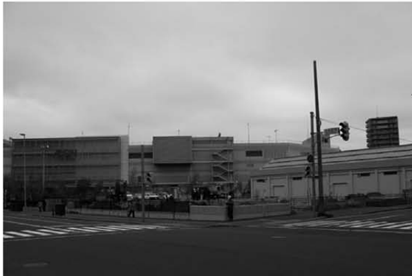
A 事業地近景(南西から)
