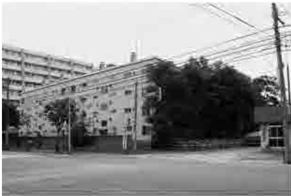
E 事業地近景(北西から)
