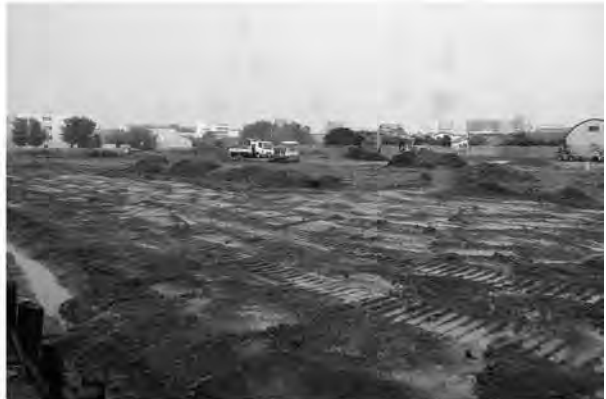
D 整理番号09-2-313 事業地近景(西から)
