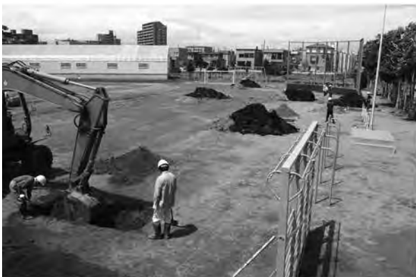
G 調査状況(東から)
