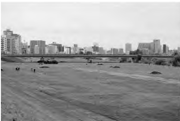
G 調査状況(南西から)
