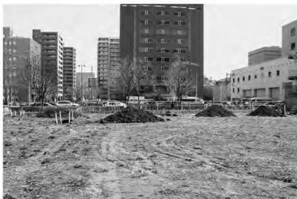
H 調査状況(西から)
