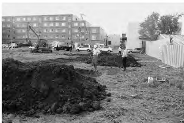
H 調査状況(北から)
