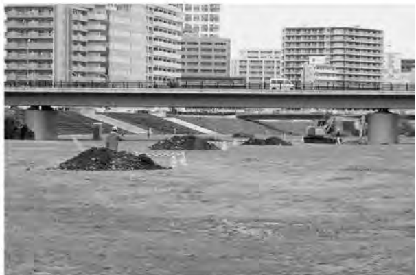
H 調査状況(南東から)
