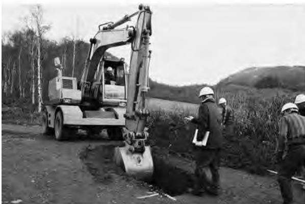
G 調査状況(南西から)
