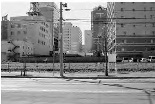
A 事業地近景(北から)
