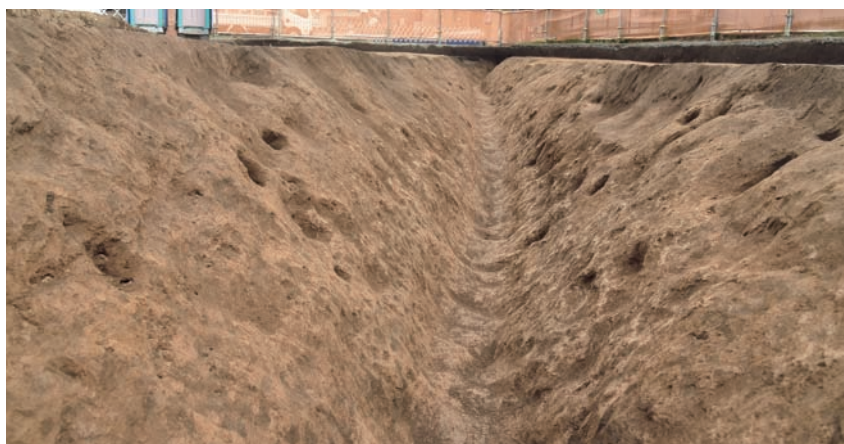
2. 58号溝跡[3区](西から)
