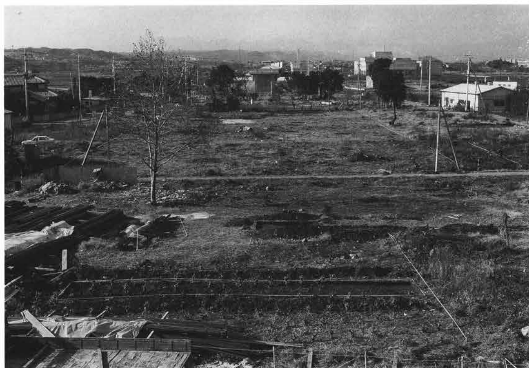
第302図 田端地区B区調査前の様子
