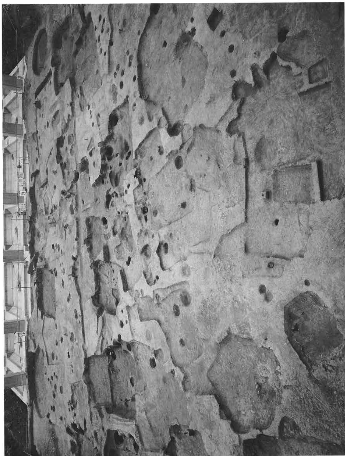
田端地区B区 71km285~315m 付近 (西から)
