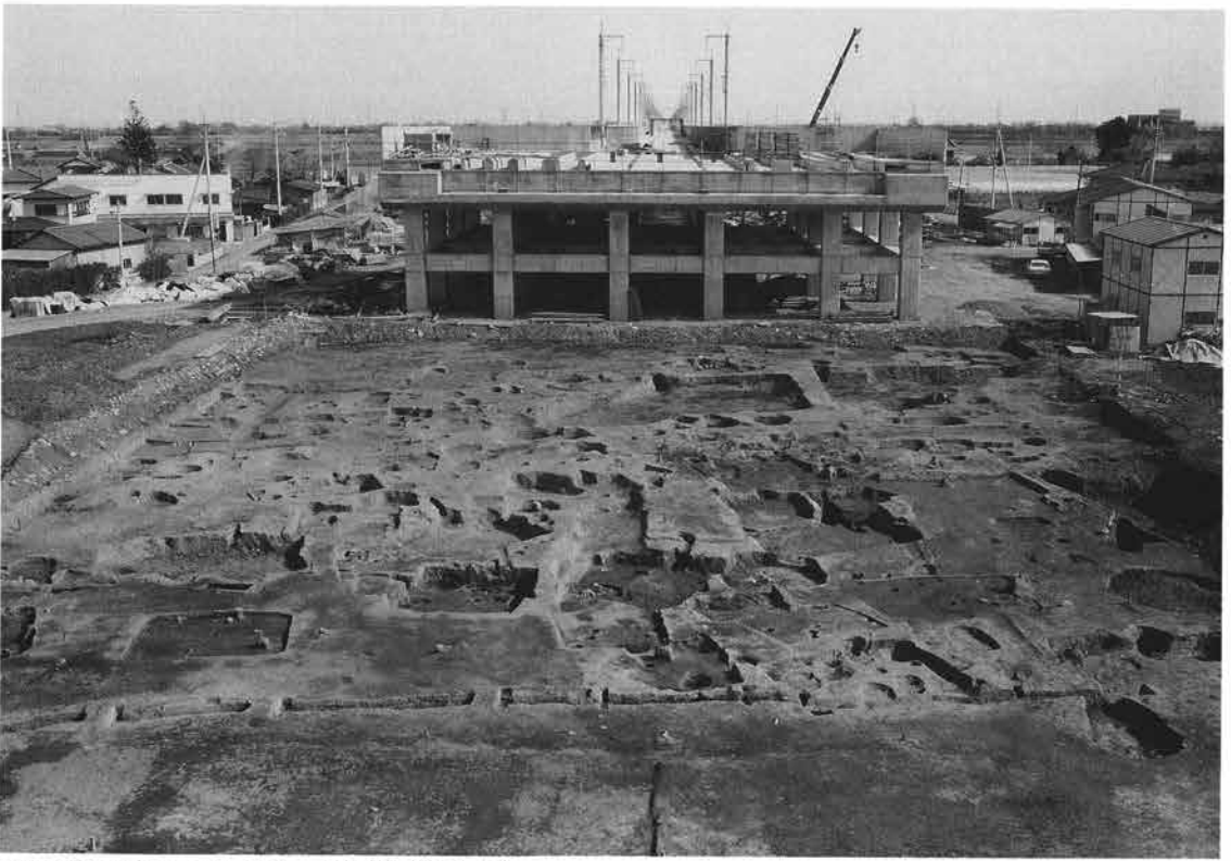
田端地区B区 71km250m 付近(1) (西から)
