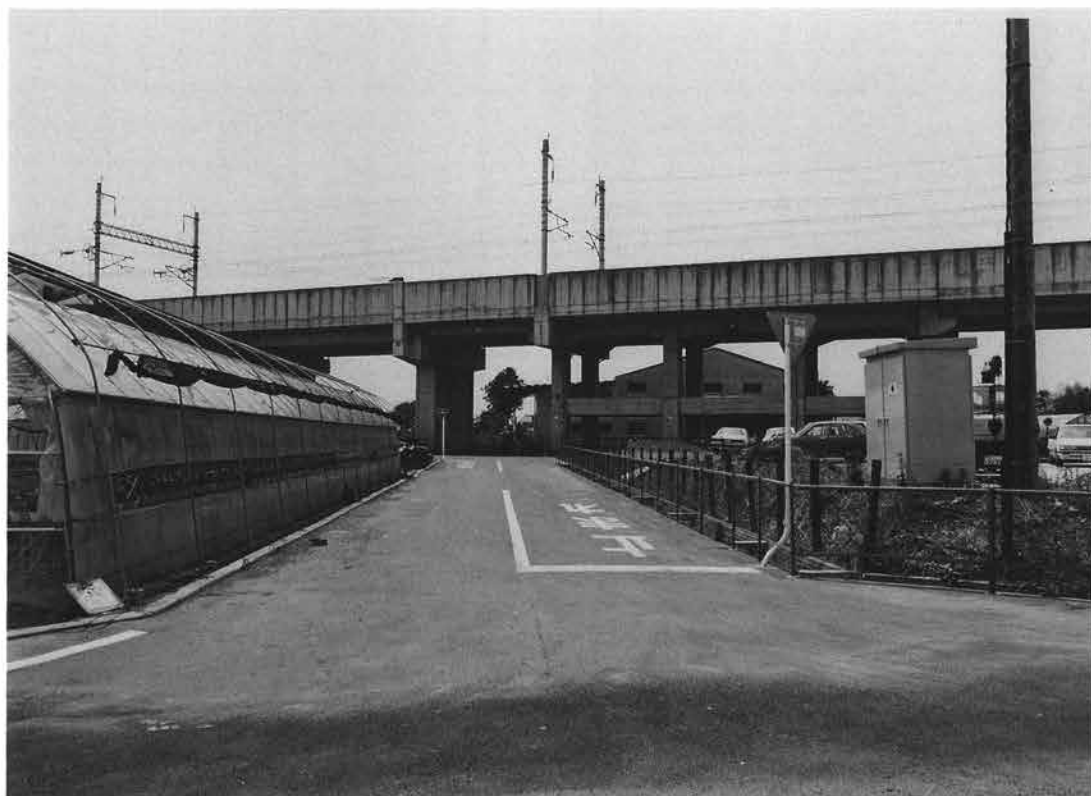
第15図 舗装工事終了後の田端地区E区（北から） 1987年5月
