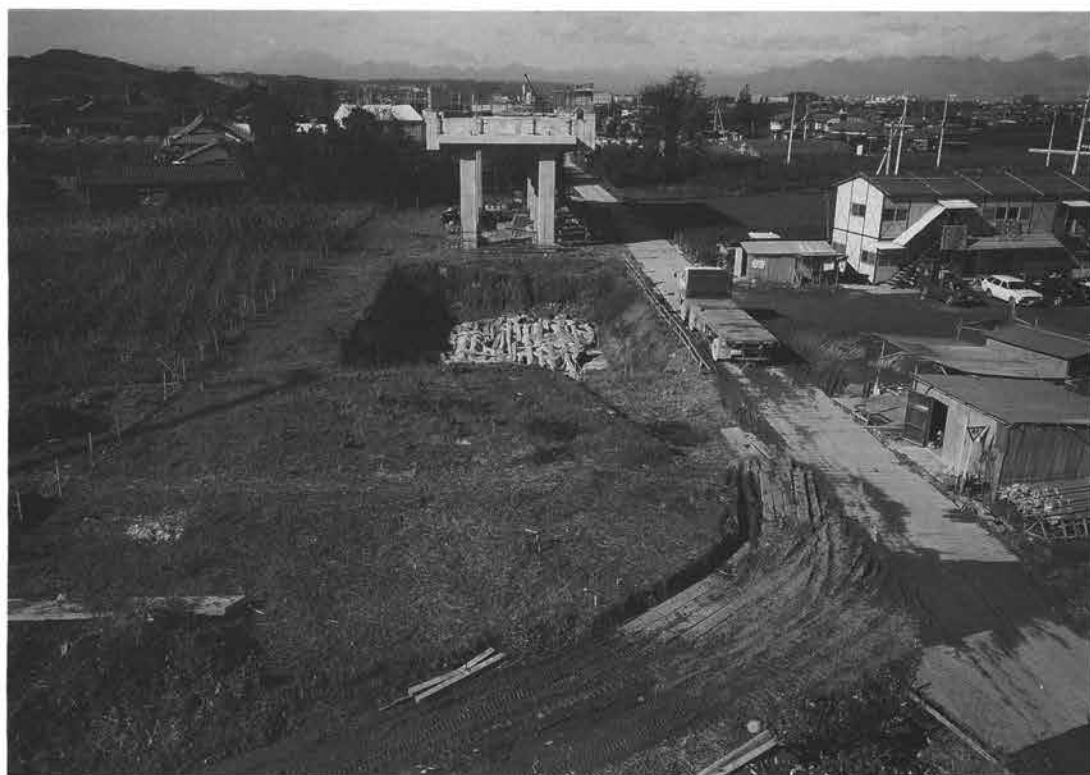
第19図 寺東地区調査前（東から）
