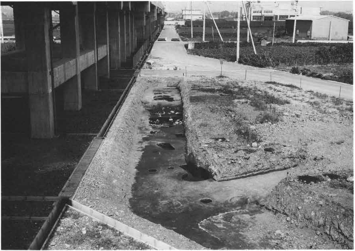
田端地区C区 北側道（東から）
