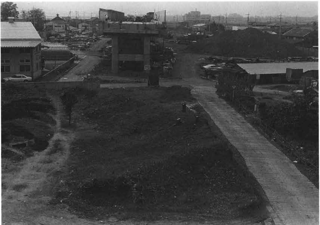
第222図 寺東地区調査前の土塁1（東から）
