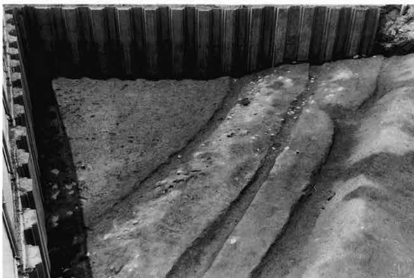
2 2区西、水田に伴う水路(東より)
