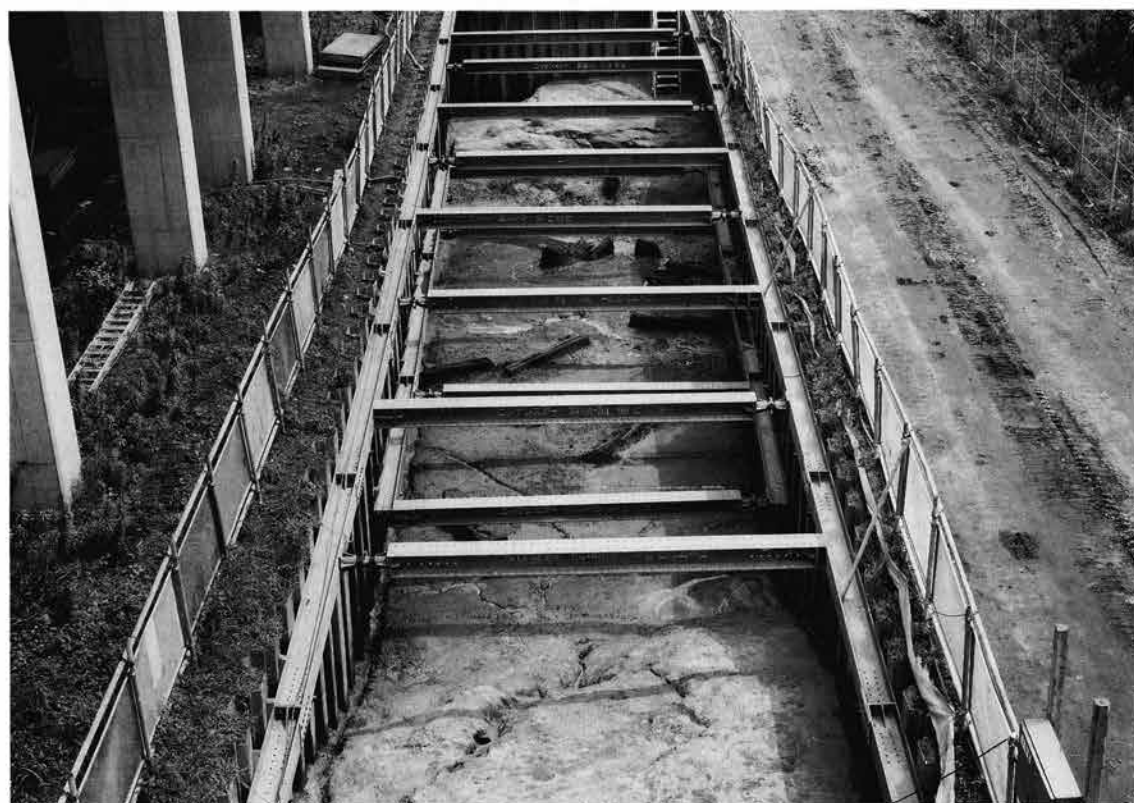
2 外縁部方向から見た北濠取水部（3区西、北より）
