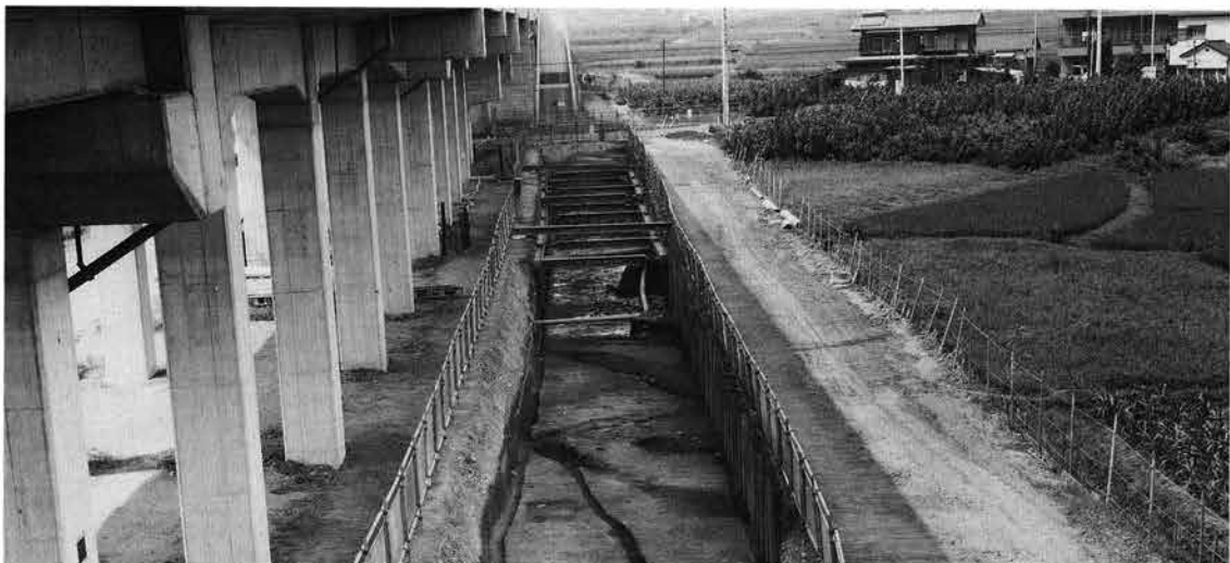
2 外縁部から見た南濠（1区東、南より）
