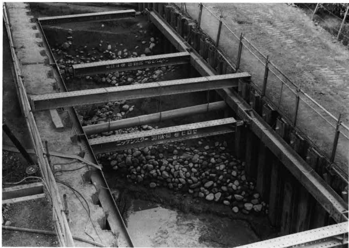
1 館南辺石垣と南辺第1張出部（南西より）
