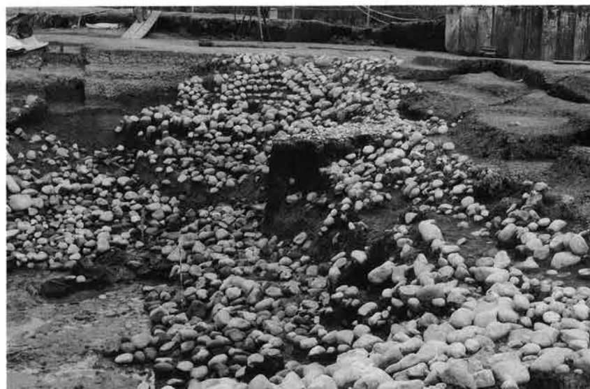
2 館西辺石垣の崩落 状態（南西より）
