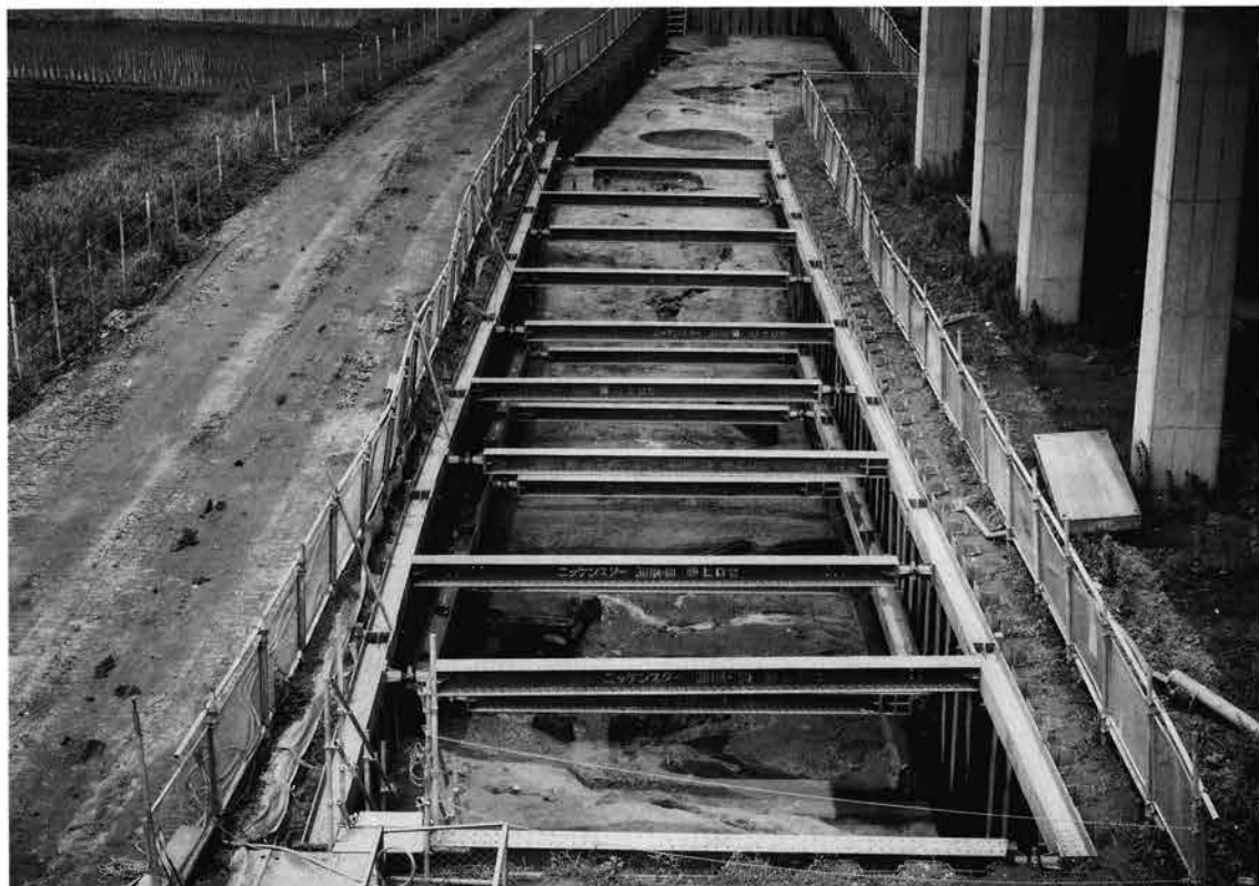
1 北濠取水部（手前は西辺第1張出部対岸の外縁部、3区西、南より）
