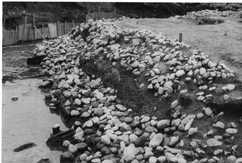
1 西辺第1張出部南 辺石垣崩落状態（南 東より）
