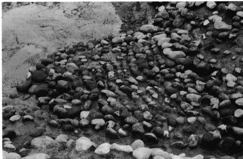
1 西辺第1張出部南 辺基部2段石垣の積 石状態（南東より）
