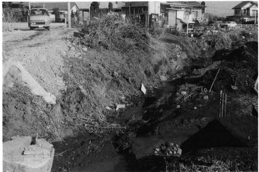
3 現猿府川によって壊されている館東辺の現況（南西より）
