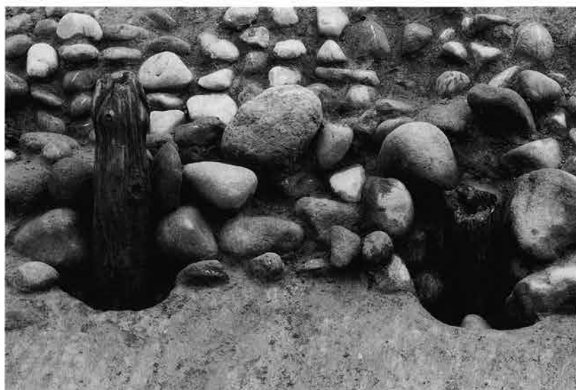
2 橋梁遺構石垣基部の支柱（北西より）
