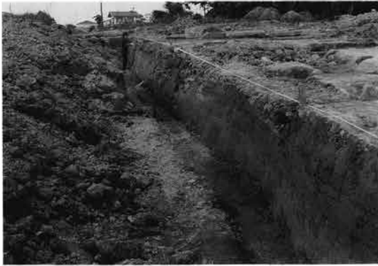
1. B区試掘トレンチ遠景
