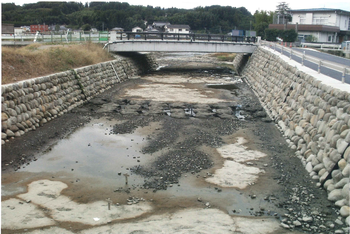
調査区工事完成後現況(北東から)
