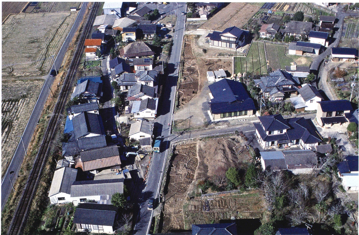
調査区全景 (上) 北より (下) 南より
