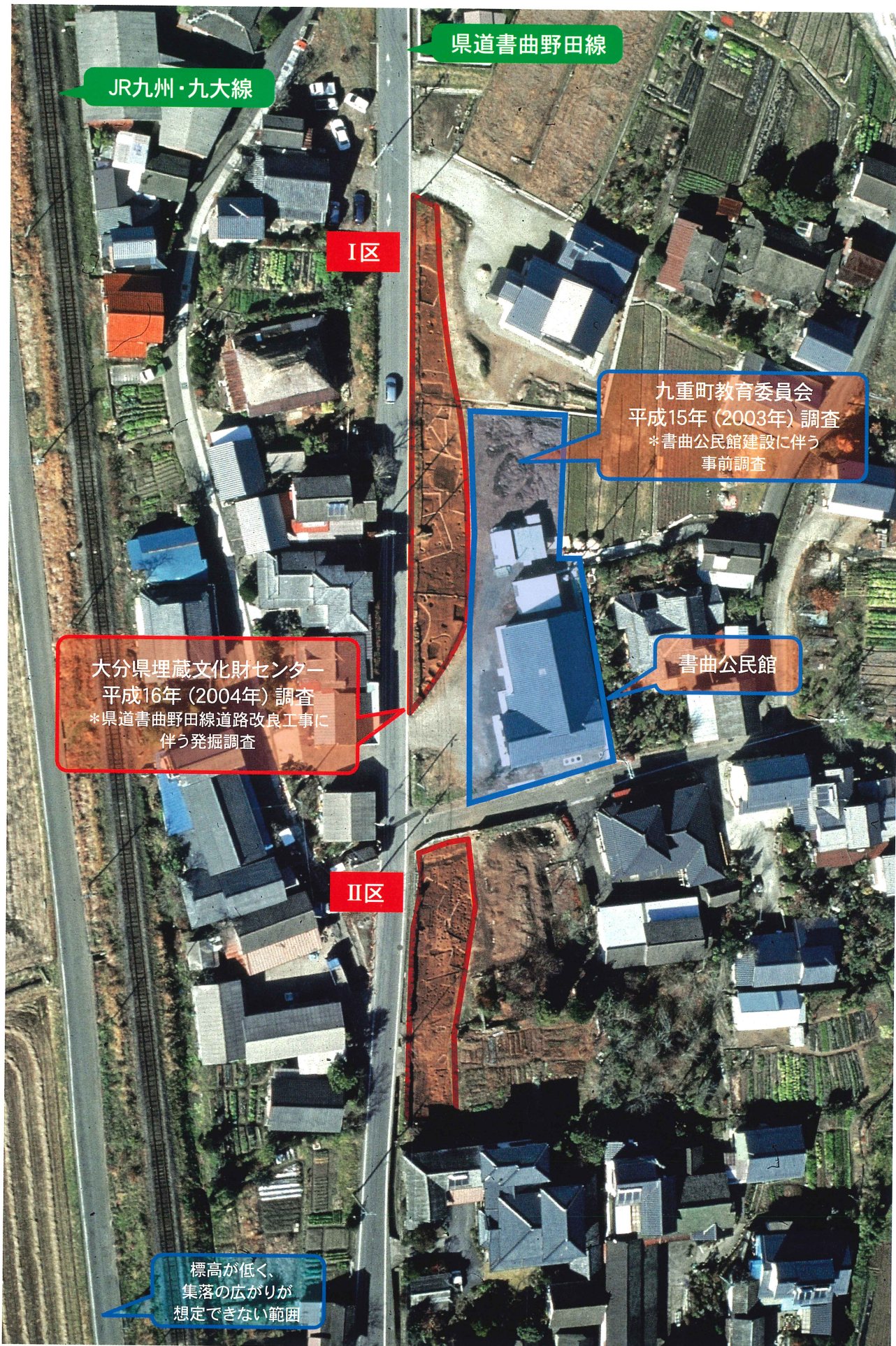
第2図 井尻日焼田遺跡周辺上空写真
