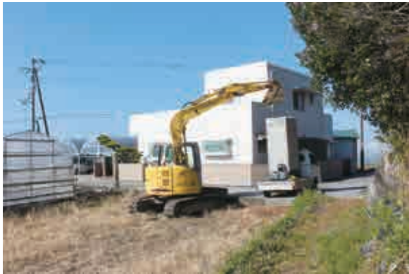
重機・仮設トイレ搬入
