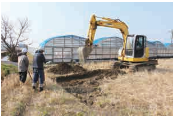
TR 5 重機掘削作業
