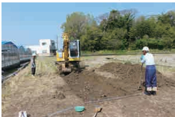
TR 7 重機掘削作業
