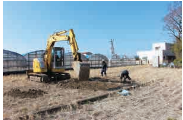
TR 1 重機掘削作業
