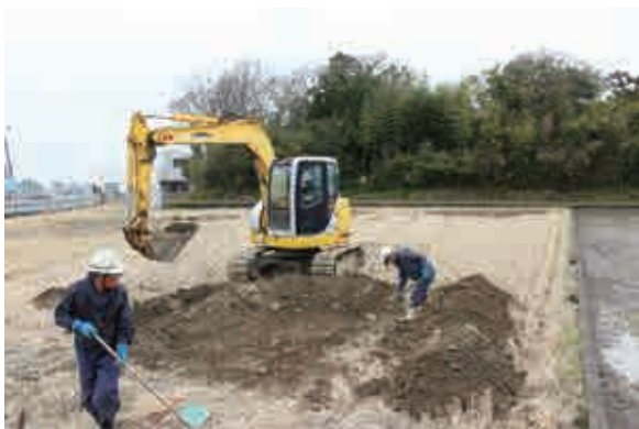
TR 4 重機掘削作業
