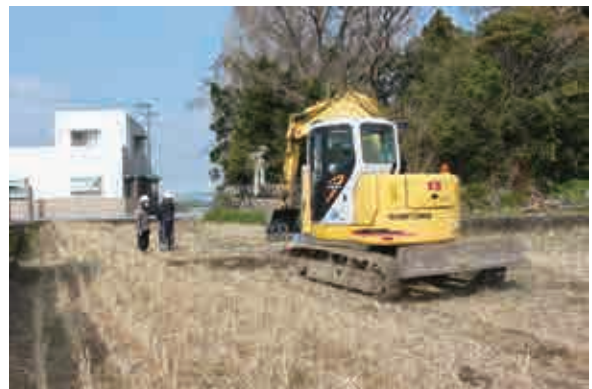
TR 6 重機掘削作業
