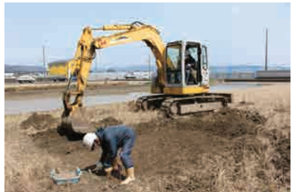
TR 3 重機掘削作業
