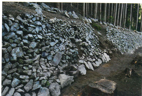
B区シシ垣内側(南から)
