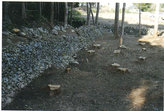
B区シシ垣内側(南から)
