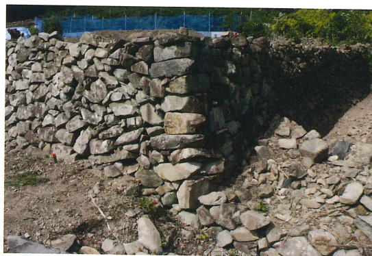
石垣D-2・石垣E(南西から)
