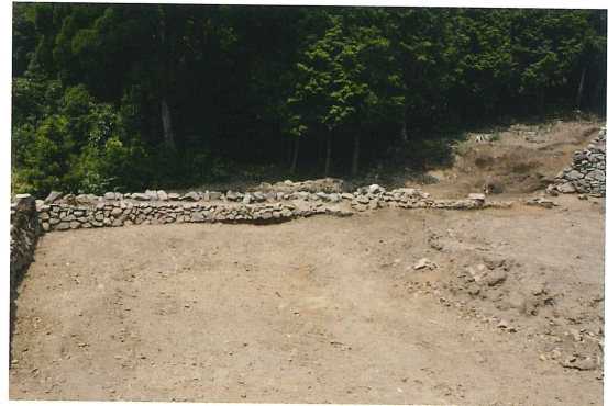
石垣B内面(南から)
