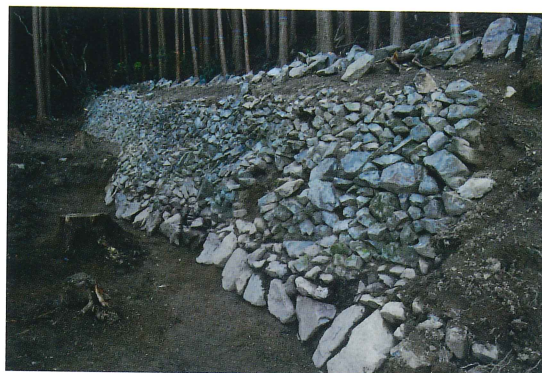
B区シシ垣内側(北から)
