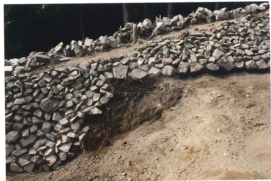
石垣A内面部分(南から)
