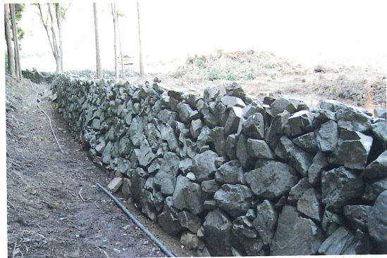
B区シシ垣外側(南から)
