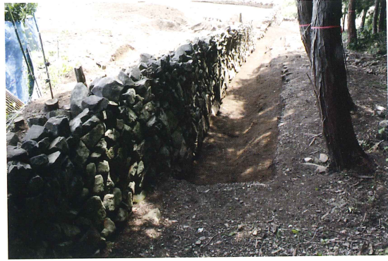
石垣A・S D001完掘状況(東から)
