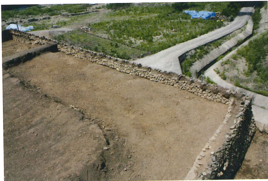
石垣D-1内面南半(東から)
