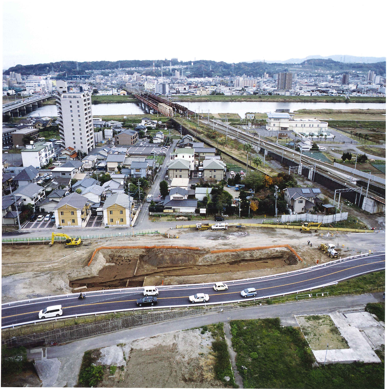
中世大友府内町跡第92次調査全景（西から）
