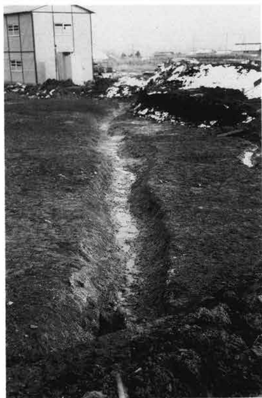
3 3号溝(北西より)
