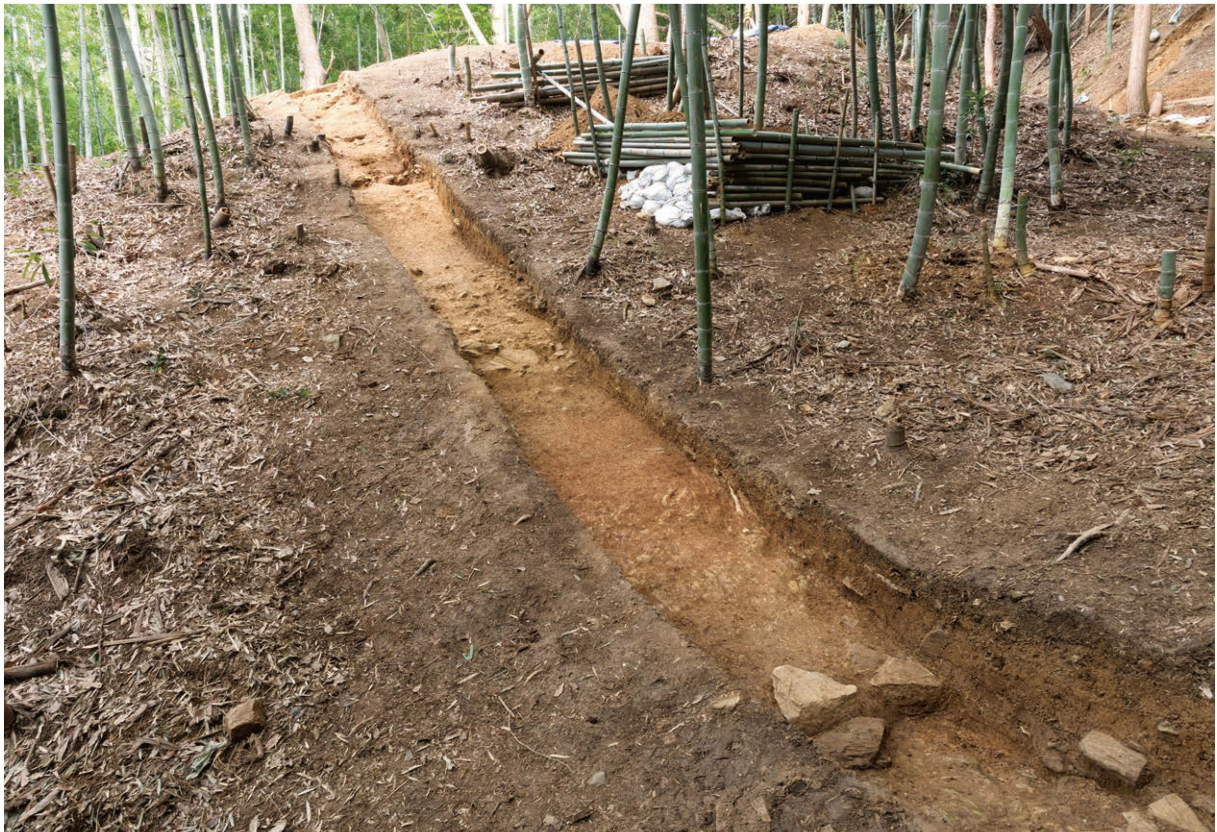
5. 墳丘部掘削状況 (南東から)
