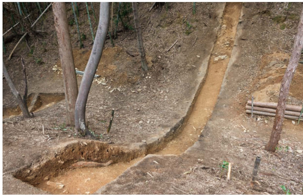
2. 掘削状況 (南東から)
