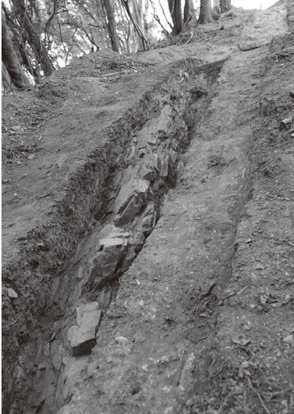
1. 1トレンチ第1段斜面断割り状況 (東から)
