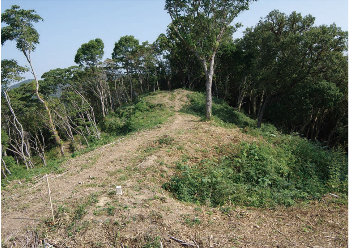
3. 天王塚古墳墳丘全景 (前方部・西から)
