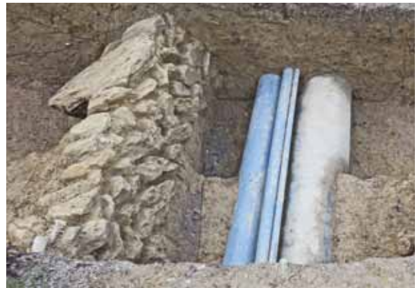
27. 7トレンチ 石垣・埋設管検出状況 (東から)
