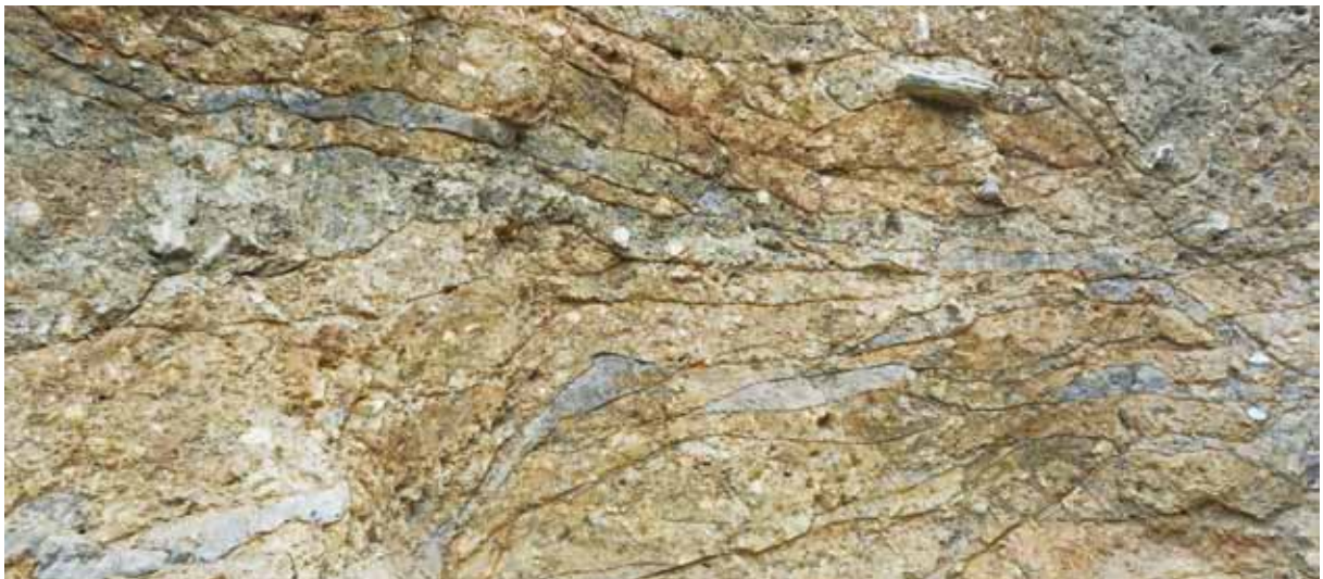
59. 羨門上部 北壁墳丘盛土（南から）
