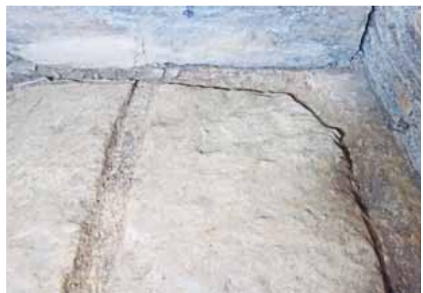
102. 玄室北東隅 排水溝完掘状況
