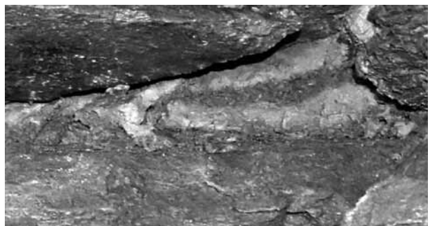
写真 10 石材の間に充填された粘土層
