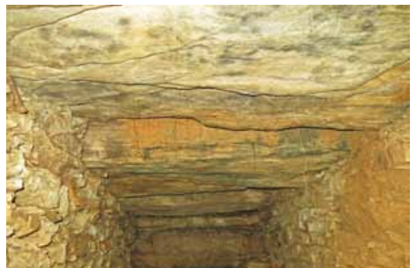
71. 羨道天井石 (南から)
