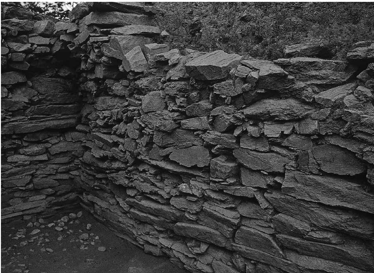
2. 玄室南側壁突起石（1箇所）（北西から）
