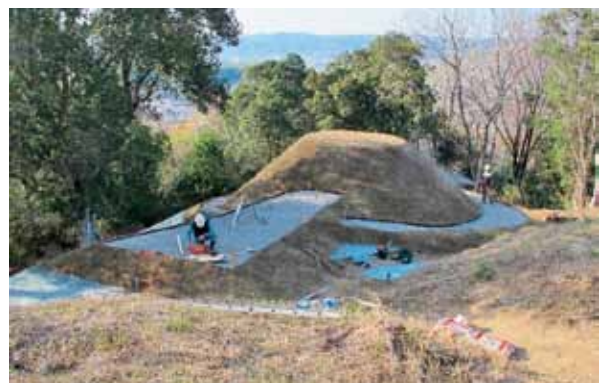
同 前方部上面砕石敷設状況
