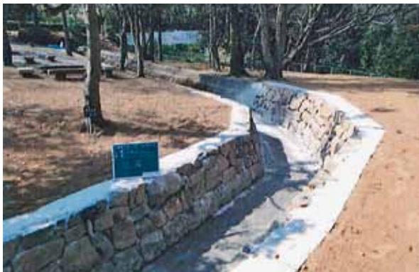
1号排水路(No.8) 完成
