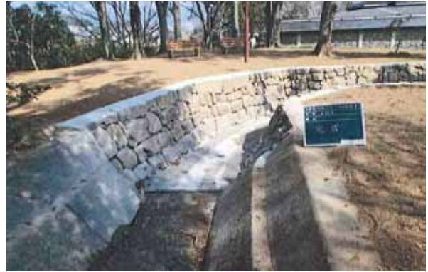
1号排水路(No.8+14.3) 完成
