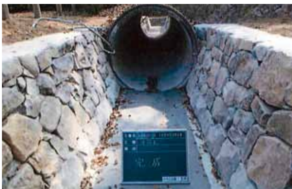
1号排水路(No.5+9.0) 完成
