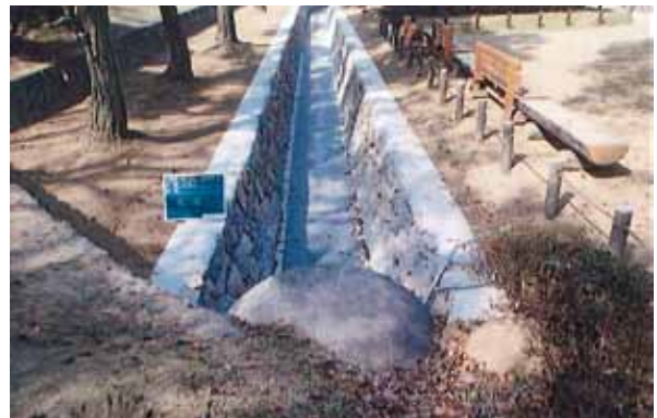
1号排水路(No.5+9.0) 完成
