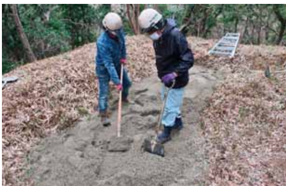
前山B42号墳 石室の埋戻し状況
