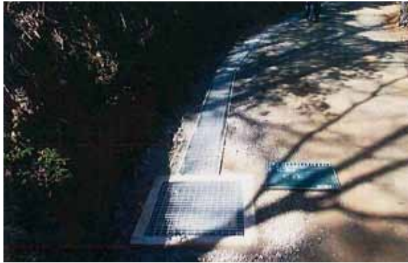
10号排水路 完成
