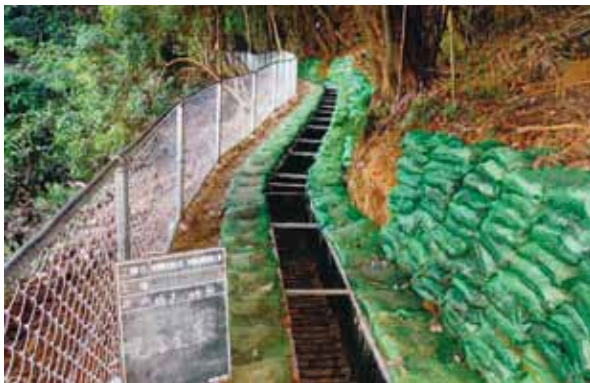
6号排水路 (No.3 ~ No.4) 完成
