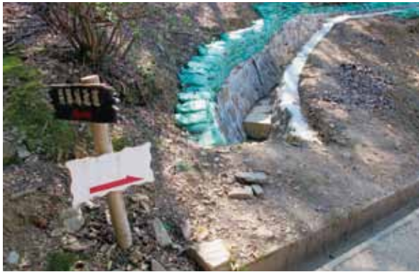
3-2号排水路(No.BP+9.0) 完成
