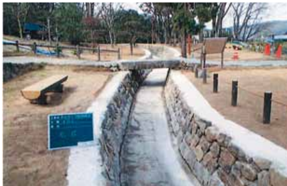
1号排水路(No.7) 完成
