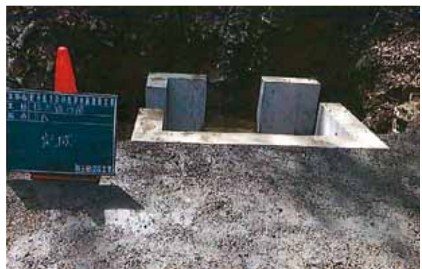
横断管接続樹 (7A) 完成
