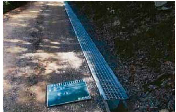
13号排水路 完成
