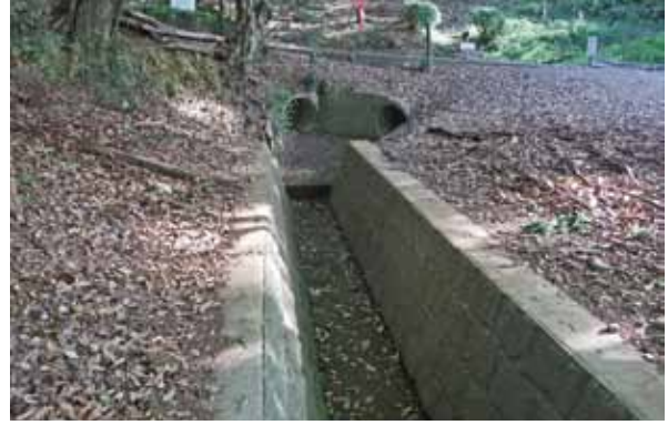
3号b排水路(E.P) 完成
