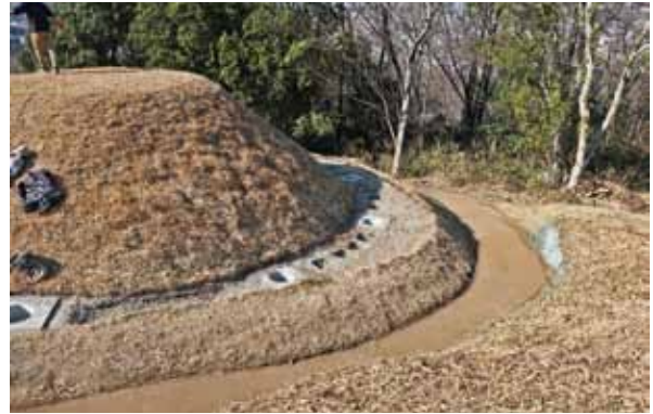
レプリカ設置用基礎工事
