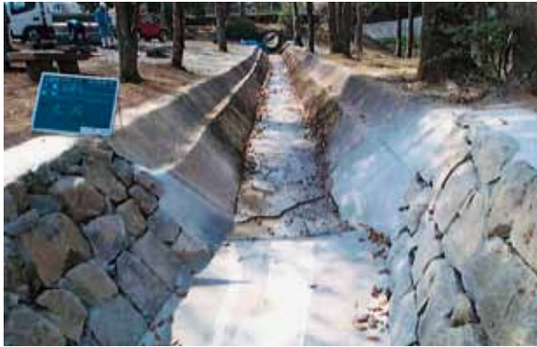
1号排水路(No.8+14.3) 完成
