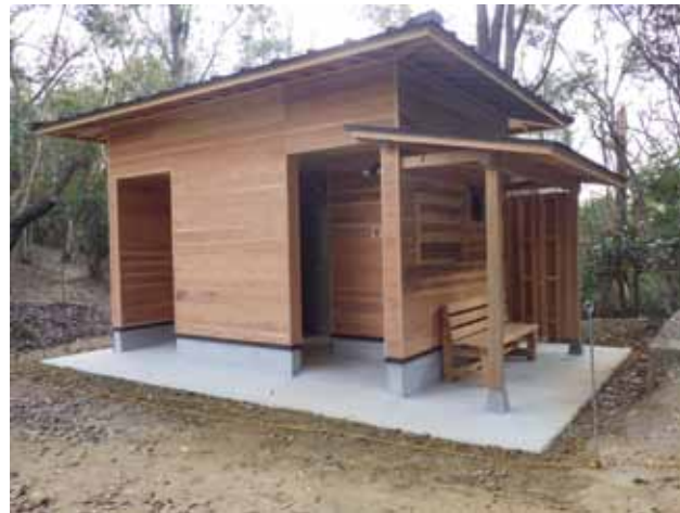
外観 (北西から)
