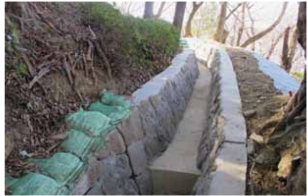
3-2号排水路(No.5) 完成
