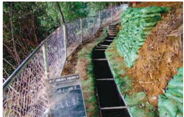
6号排水路 (No.2 ~ No.3) 完成
