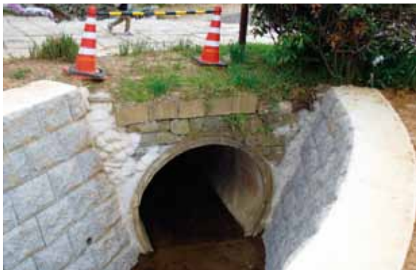
1号排水路(No.1+0.5) 完成
