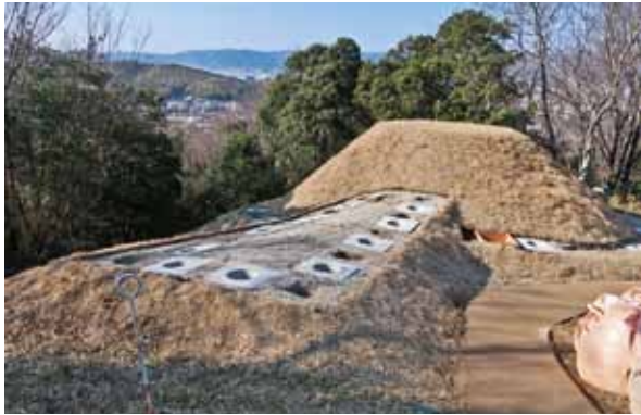
レプリカ設置用基礎工事
