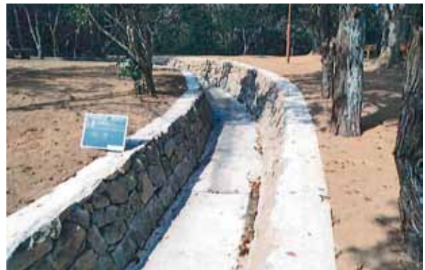
1号排水路(No.8) 完成
