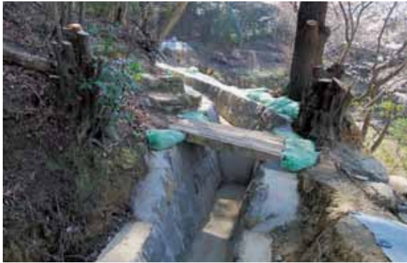
3-2号排水路 (No.9) 完成
