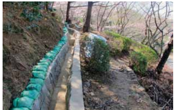
3-2号排水路(No.8) 完成
