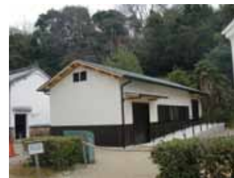
外観 (北西から)
