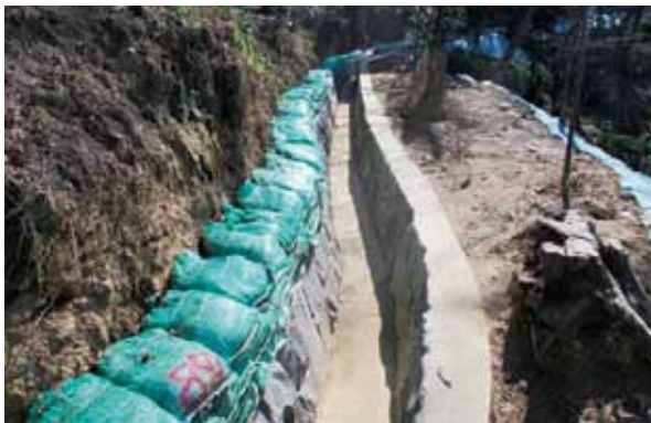
3-2号排水路(No.6) 完成
