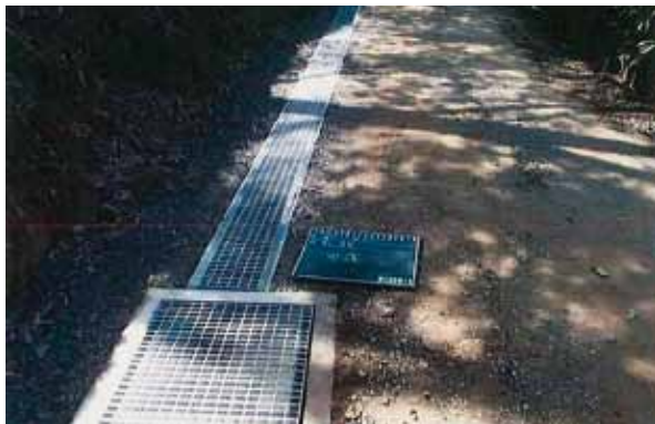
13号排水路 完成
