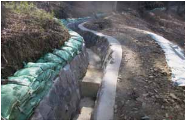
3-2号排水路(No.3) 完成
