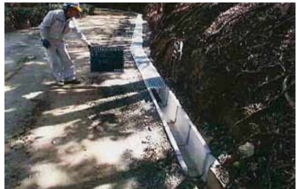
15号排水路 完成
