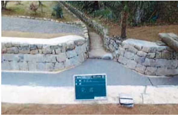
1号排水路(No.2+12.4) 完成
