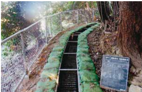
6号排水路 (B.P ~ No.1) 完成
