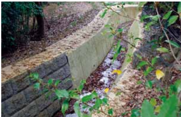
3号a排水路(E.P) 完成
