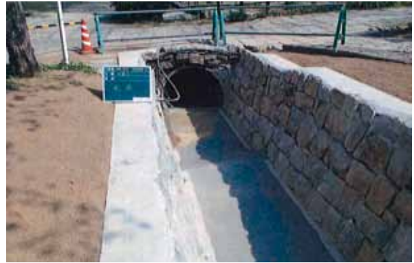
1号排水路(No.1+5.5) 完成
