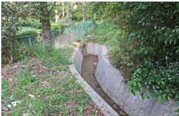
3号a排水路(B.P) 完成
