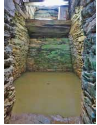
玄室滞水状況
