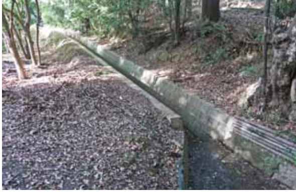
3号b排水路(E.P ~ No.1) 完成
