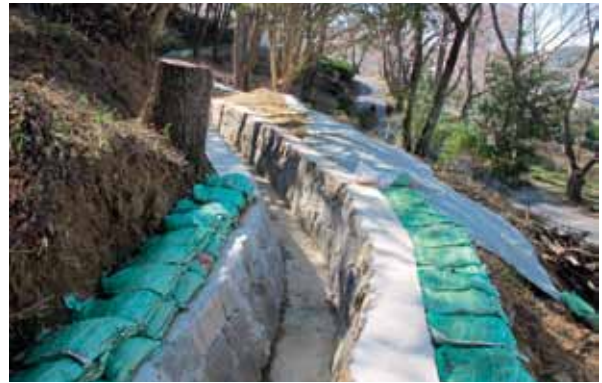
3-2号排水路(No.2) 完成
