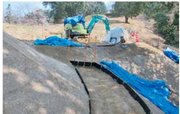
同 墳丘盛土状況（前方部）
