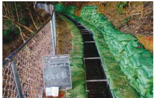
6号排水路 (No.4 ~ No.5) 完成
