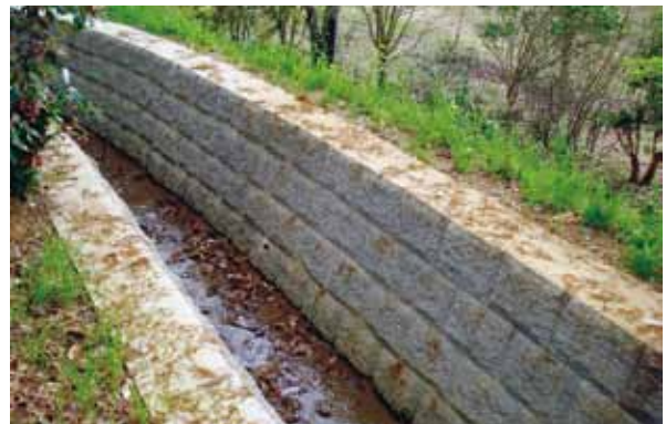
3号b排水路(No.1 ~ No.2) 完成
