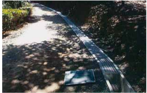
10号排水路 完成
