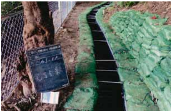
6号排水路 (No.5 ~ E.P) 完成
