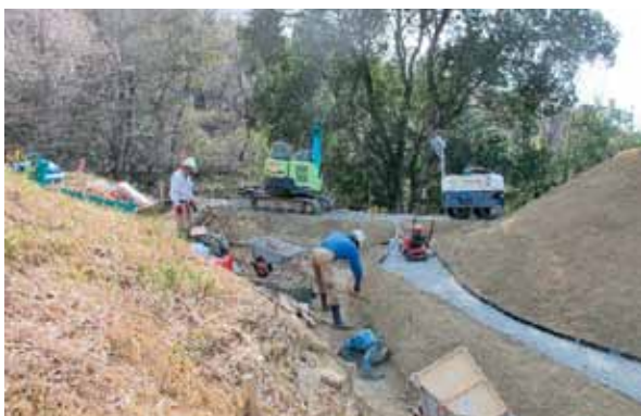
同 後円部テラス砕石敷設状況
