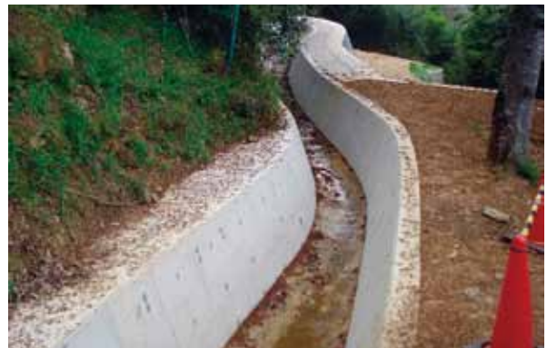
3号a排水路(B.P ~ No.1) 完成
