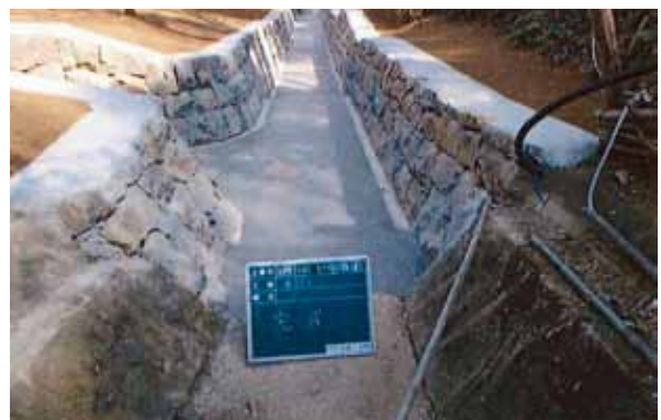
1号排水路(No.4+6.6) 完成
