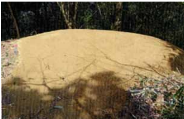
前山B153号墳 石室埋戻し・真砂土による墳丘盛土
