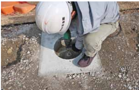
レプリカ設置用基礎への水抜き穴の貫通作業 (委託)
