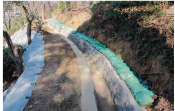
3-2号排水路 (No.11) 完成
