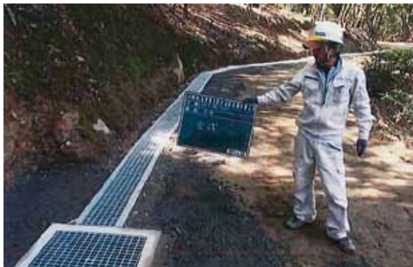
15号排水路 完成
