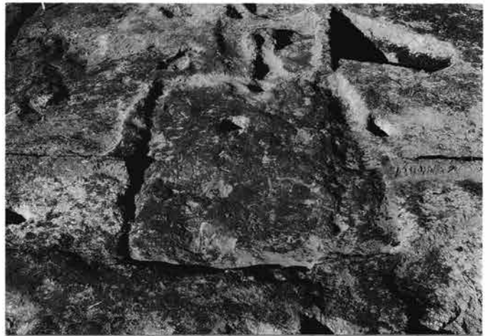
4. SB49建物 南より
