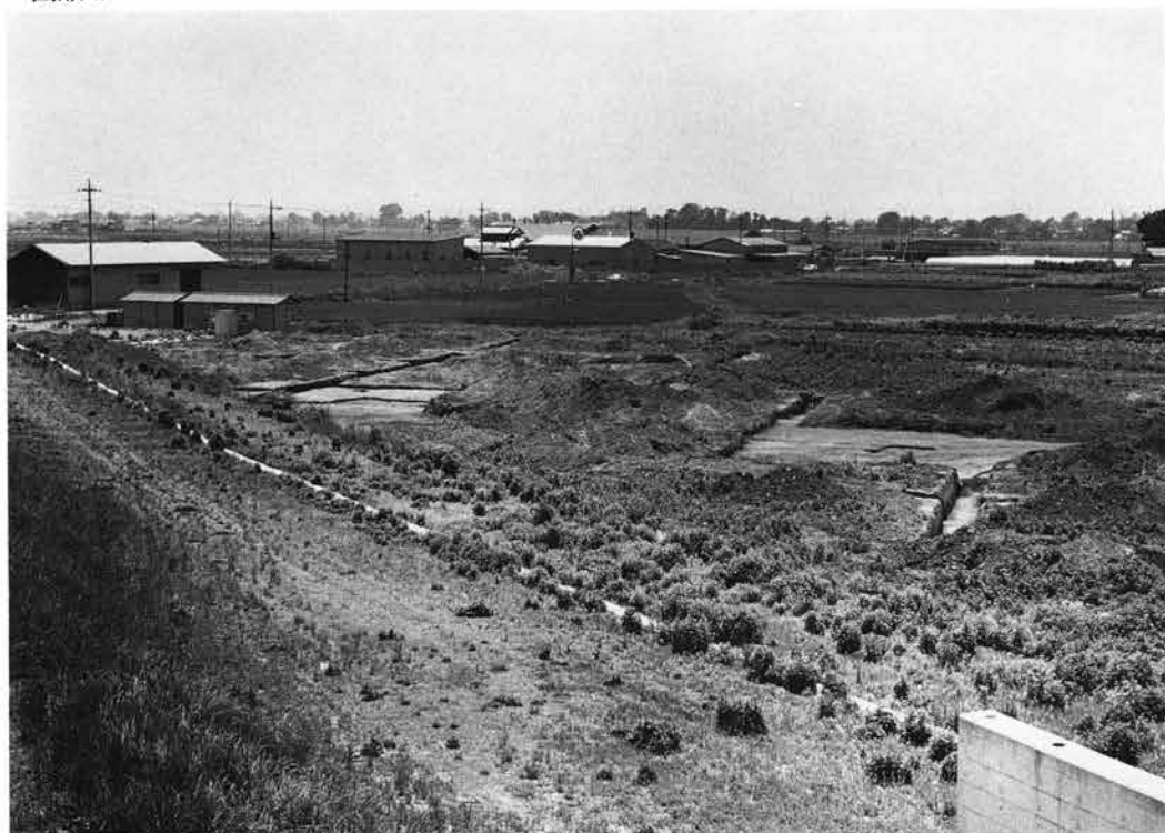
1. 遺跡全景（北西より）
