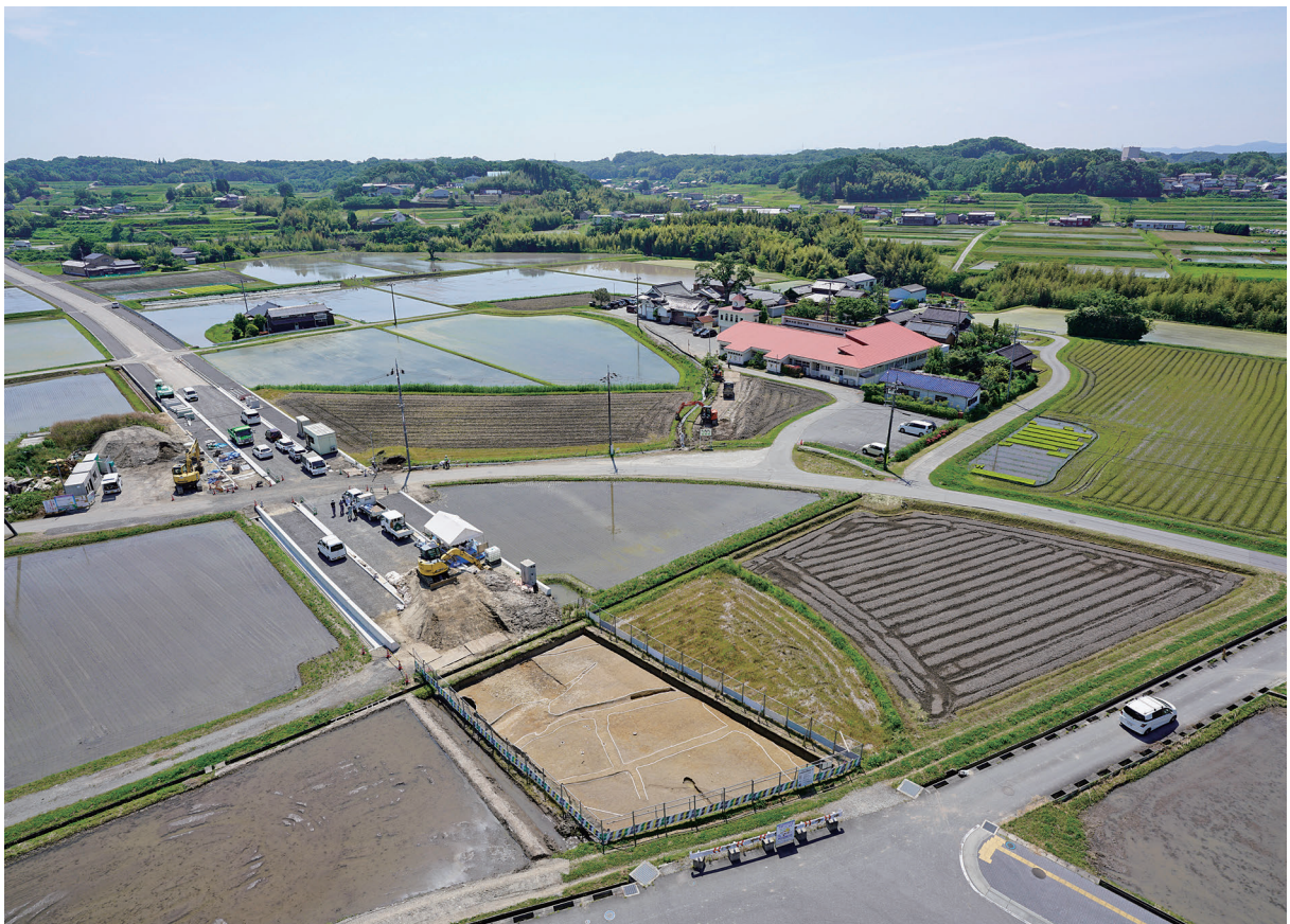
2. 近景（北西上空から）
