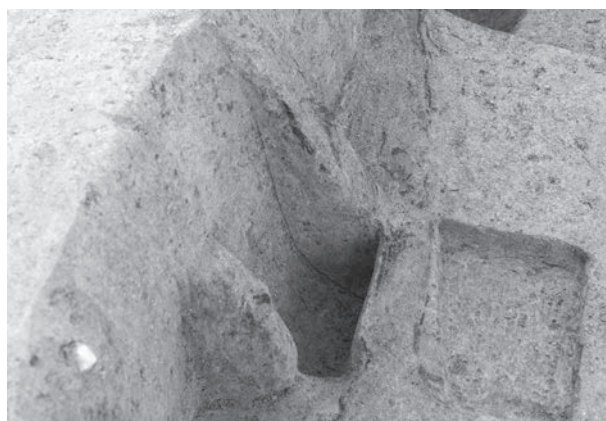
SH57 壁構築材 (eから)
