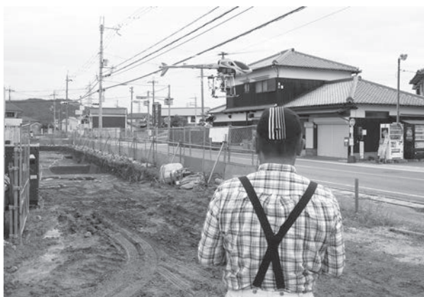
⑧ 空中写真撮影状況（北西から）
