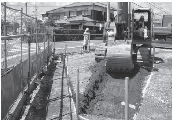
⑤ 機械掘削状況（東から）
