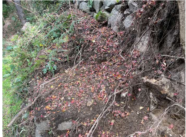
図 130 石垣付近での掘り返し(石垣 6・7)
