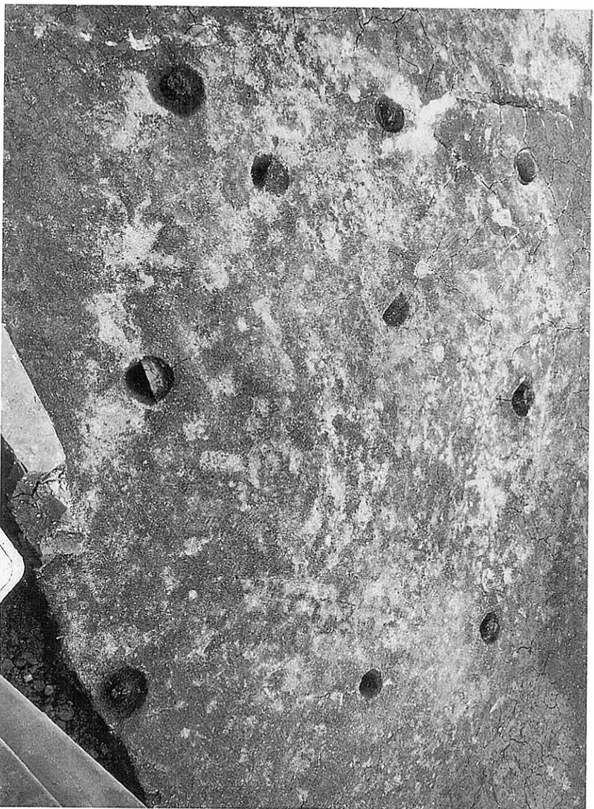
D-2トレンチ 建物-5全景
