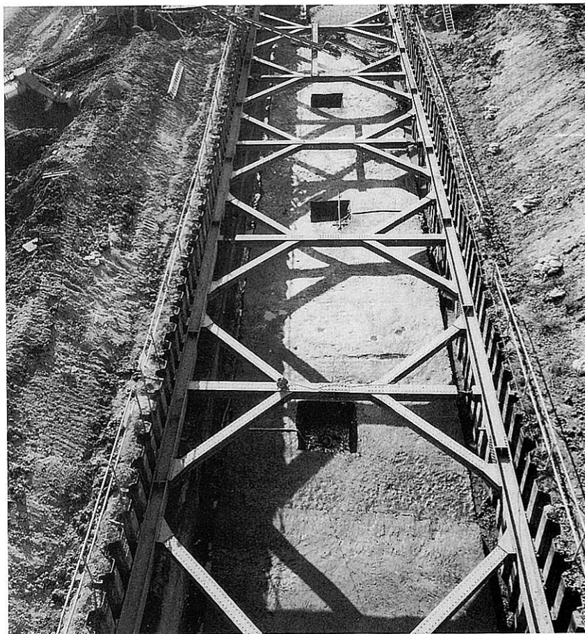
Aトレンチ 最終掘削面(手前)
