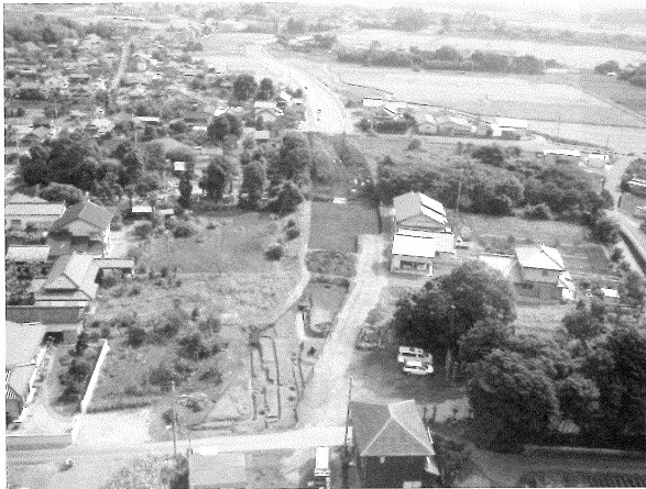
区域2 全景(西から)
