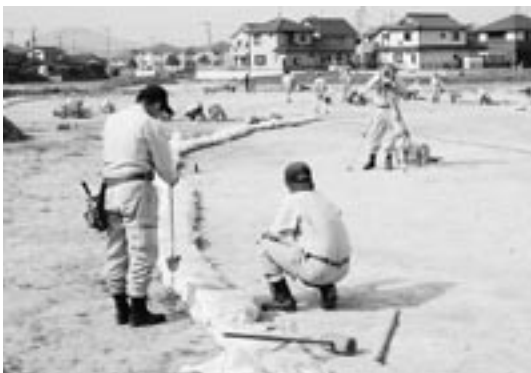
国土座標杭設置（今市遺跡）
