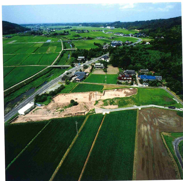
1次調査区全景 (南から)
