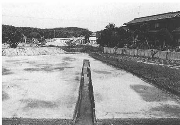
TR 3 完掘 (西より)
