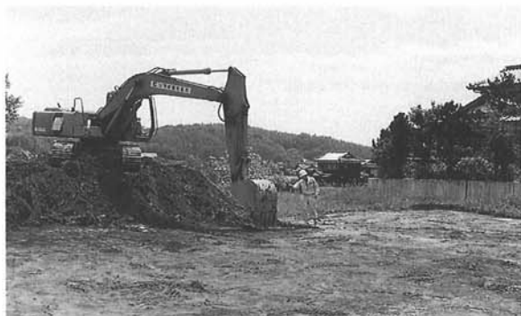
重機による表土除去作業
