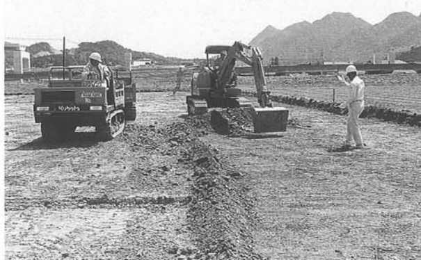
重機による表土除去作業
