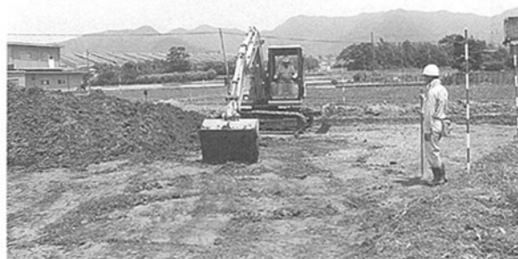
重機による表土除去
