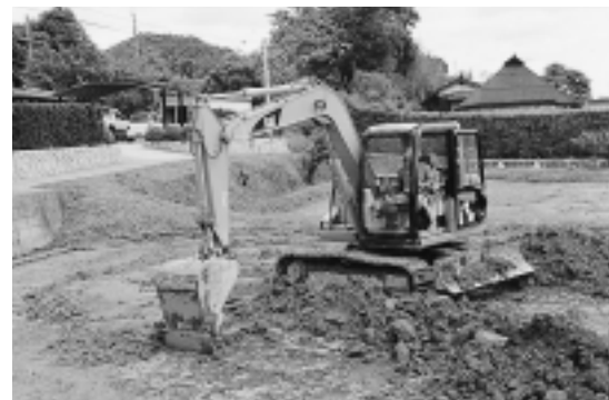
重機による表土除去作業
