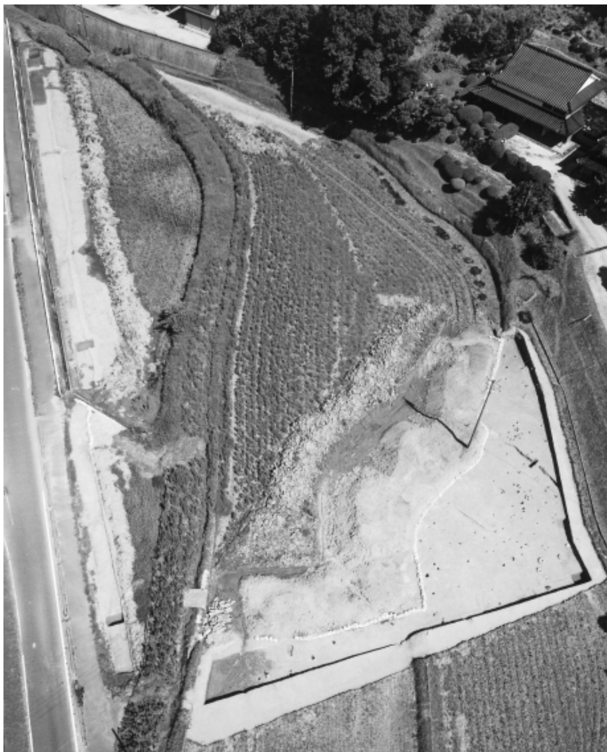
I 地区全景（南東から）
