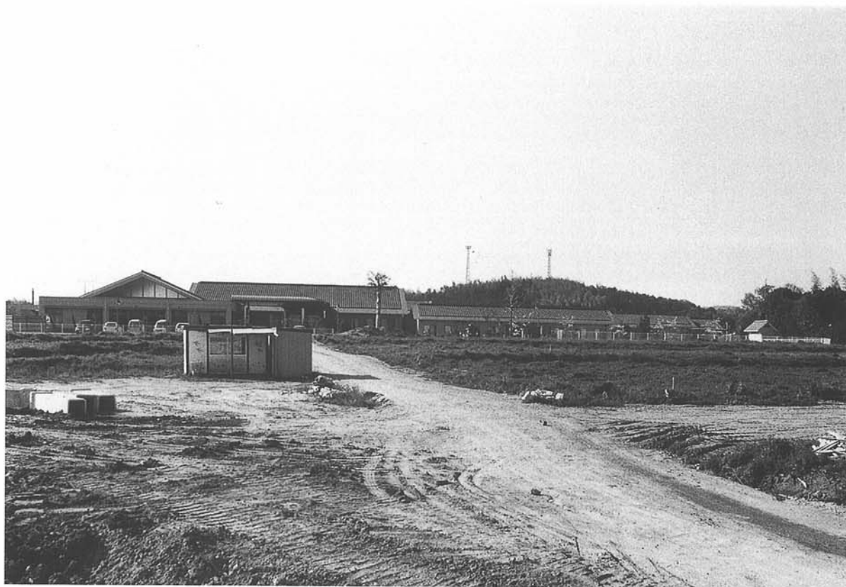
調査前風景（南より）
