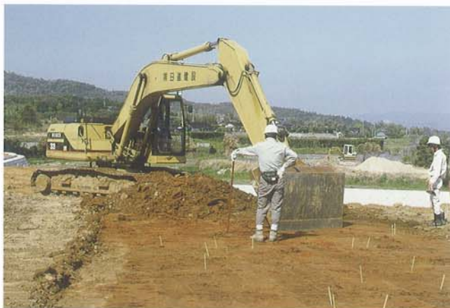
重機による表土除去
