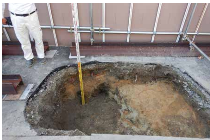
調査区3 南壁地層断面 (北から)
