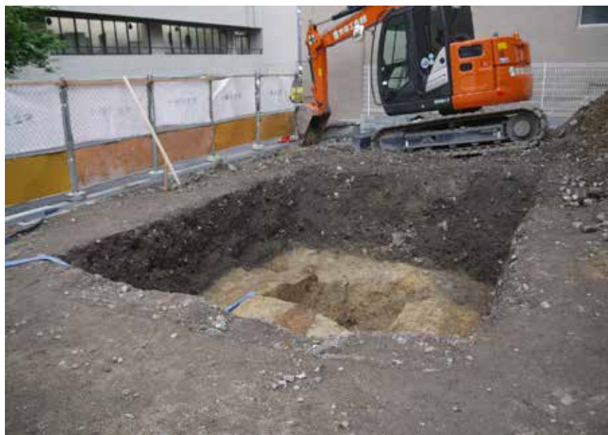
調査区全景(南西から)
