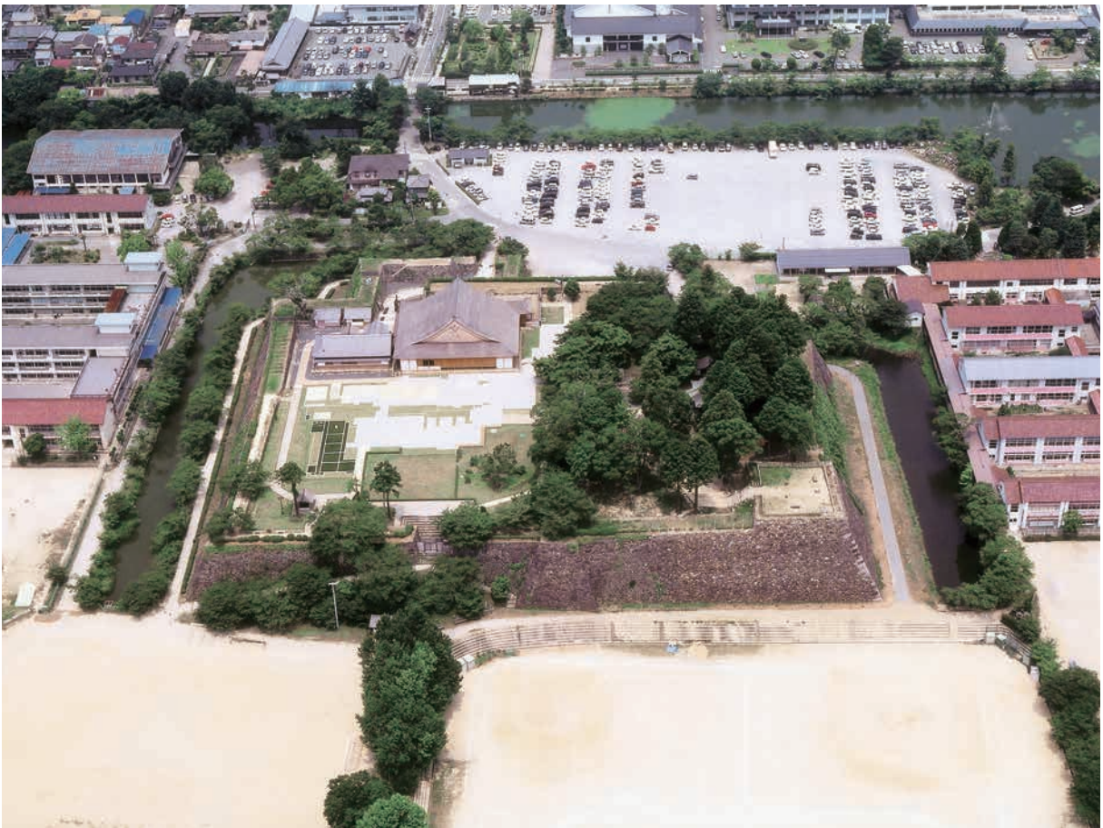
調査地遠景（南から） 平成14年 7月撮影
