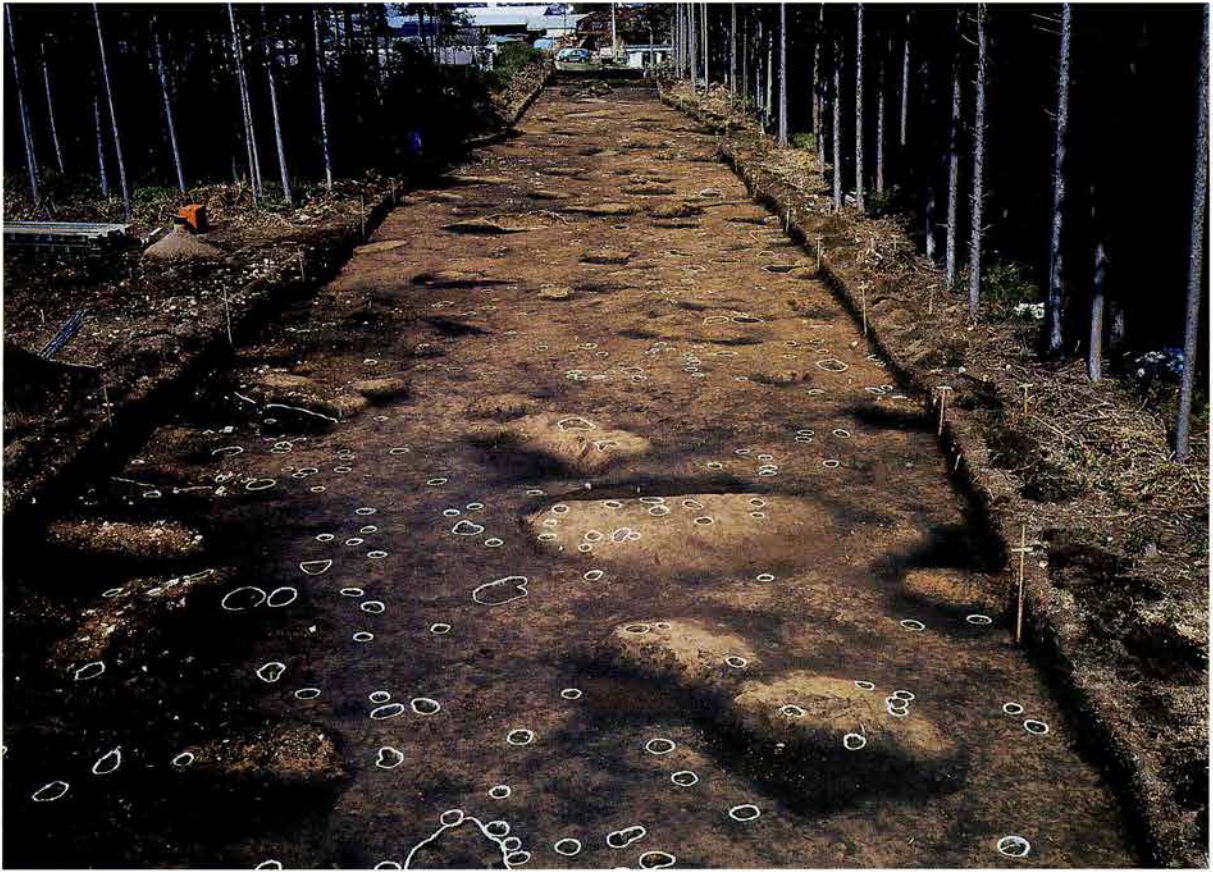
I 地区 全景 (南東から)
